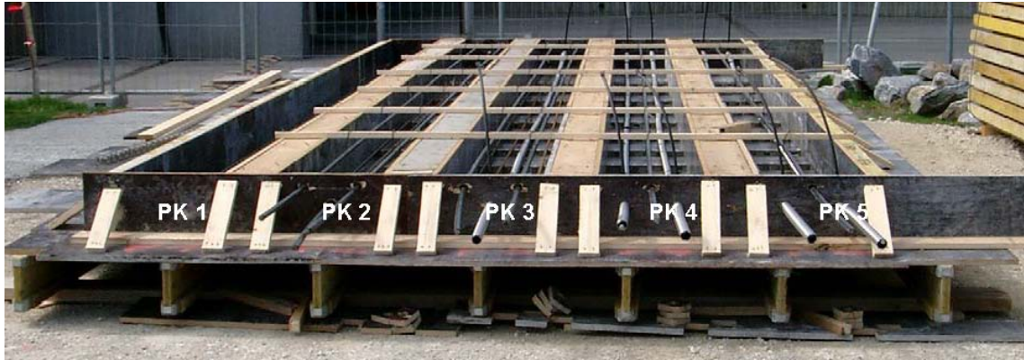
Abbildung 4.9: Schalung für die Probekörper
