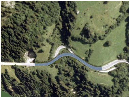
(a) Ansicht der Strasse von oben
