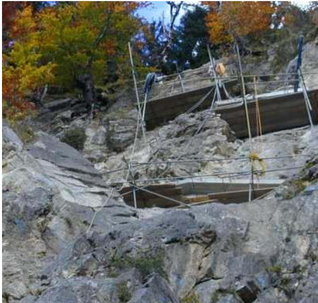
**Abbildung 27 Arbeitsplatzsicherung Ankerarbeiten**
