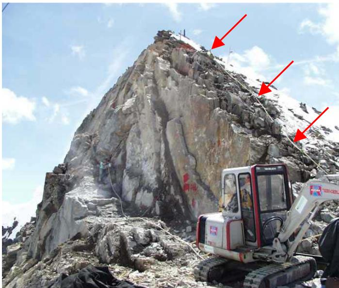
Abbildung 26 Zugangsweg - Seilsicherung
