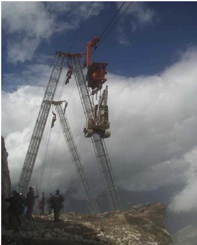
**Abbildung 18 Baggertransport mittels Materialseilbahn**
