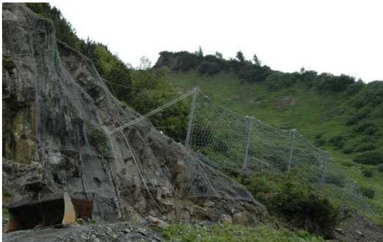
**Abbildung 8 Steinschlagnetz**
