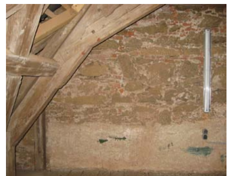
76 Turmmauerwerk unter Dach, verputzter Fußbereich
