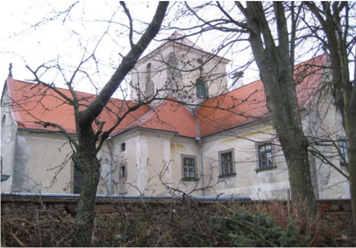
Westansicht, Blick auf den Vorbau der Wendeltreppe 73
