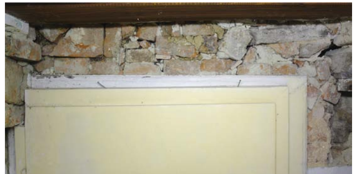
156 Putzfenster 4D Wand E, Ziegel vor dem Balkenkopf
