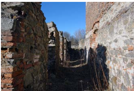
umlaufender Gang, Westseite 94
