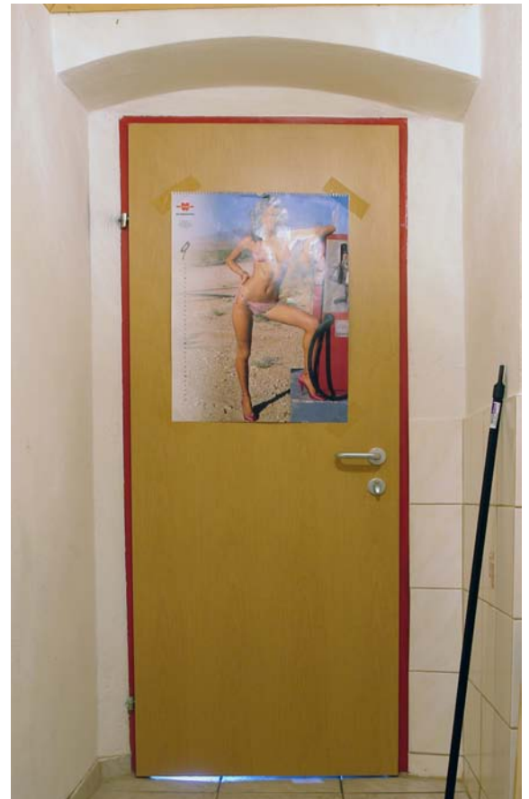
114 T016, ehem. Durchgang mit Sturzbogen
