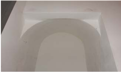
Gewölbe Raum 2A 131
