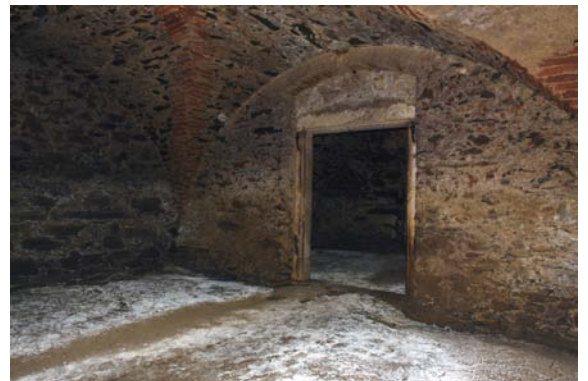
18 Keller, Innenraum mit Kreuzgratgewölbe
