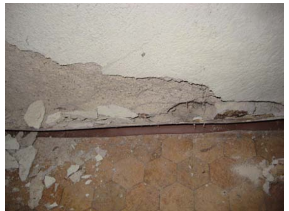
187 abgeplatzter Zementputz
