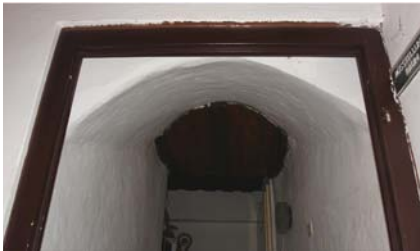
Gewölbe Raum 2B 132
