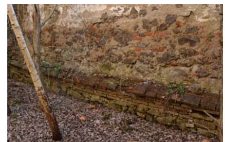
96 Keller, Südwand Gewölbeauflager
