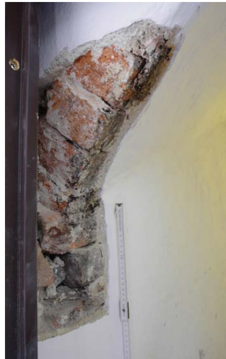
138 freigelegtes Gewölbe Raum 2B
