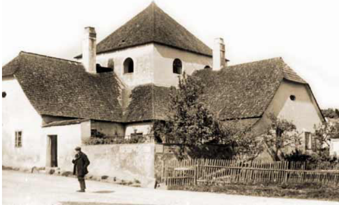
Döllersheim, Spital, Ansicht von Südwesten 88
