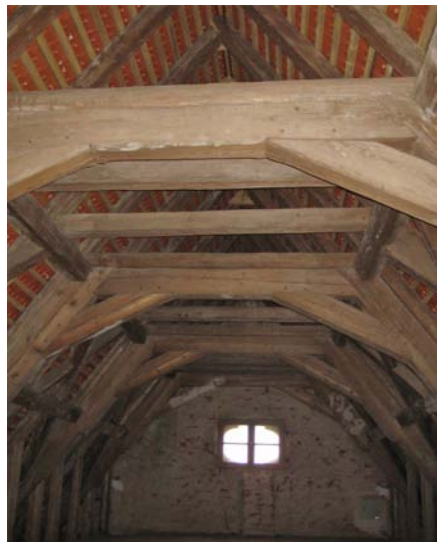
Dachstuhl, Giebel mit Ovalfenster 76
