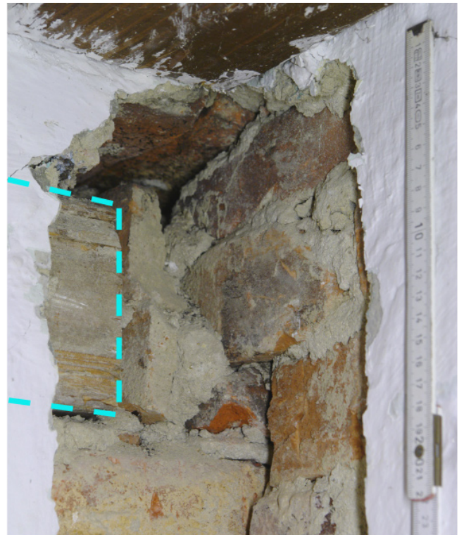
151 Putzfenster 4C2, markierte Balkenlage
