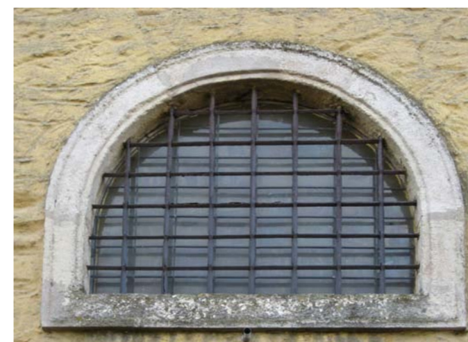
Rundbogenfenster, Kirche Weitersfeld 104
