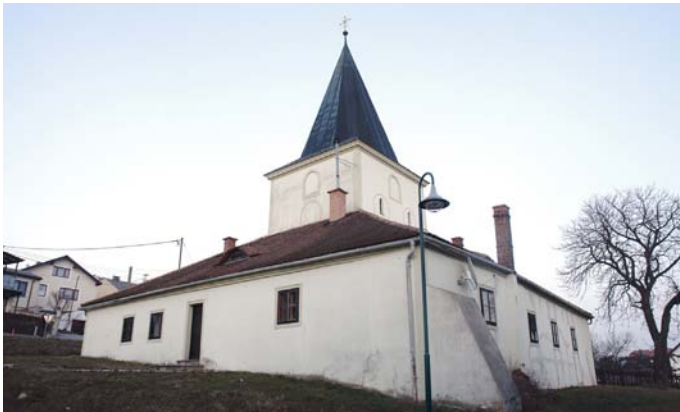
Ansicht von Süd-West 36
