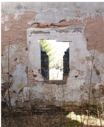
Döllersheim, östliche Turmwand, Türe 174
