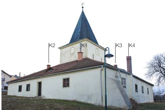
Ansicht von Südwest, Kamine 1-4 56
