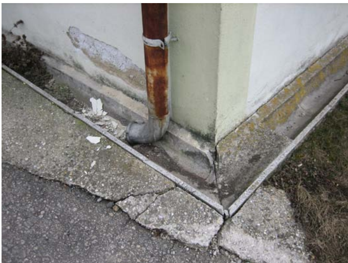
183 Nordwestecke, betonierte Rinne
