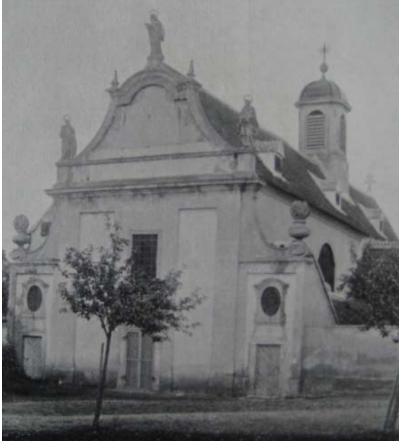
Röhrenbach, Spital, Ansicht von Süden 78
