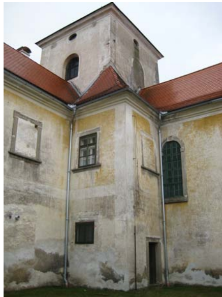
Nordansicht, umlaufender Gang 74
