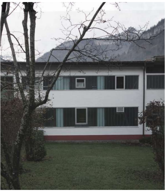
41 Halle 2 | Fassade Ost
