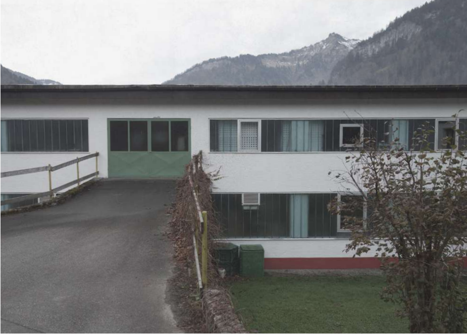
40 Halle 2 | Fassade Ost
