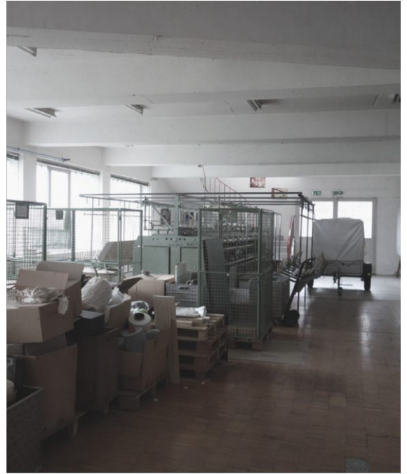
45 Erdgeschoss Halle 1 | Lager
