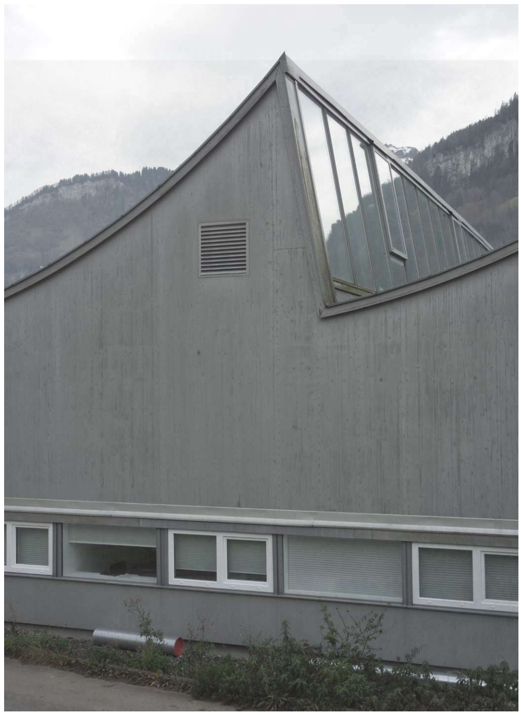
54 Halle 4 | Blick zu Sheddach
