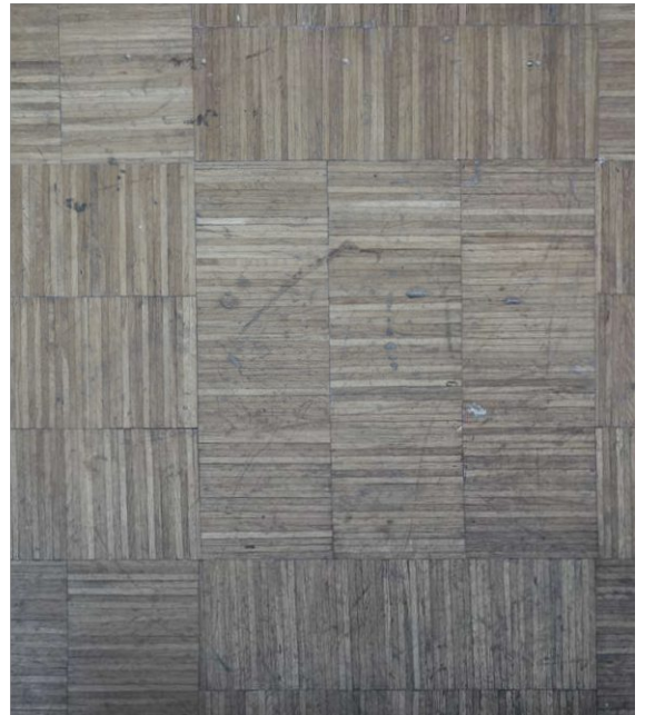
46 Erdgeschoss Halle 1 / 2 | Industrieparkett
