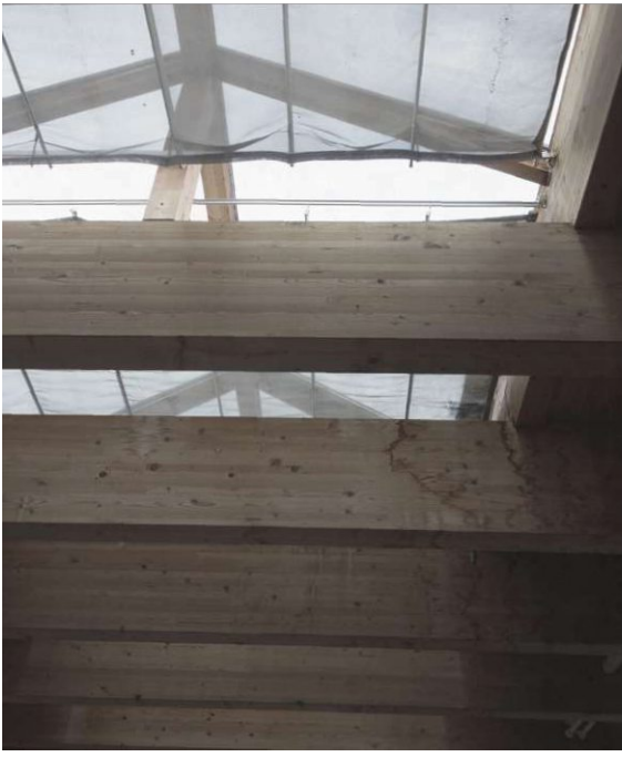
49 Obergeschoss Halle 1 / 2 | Dachstuhl
