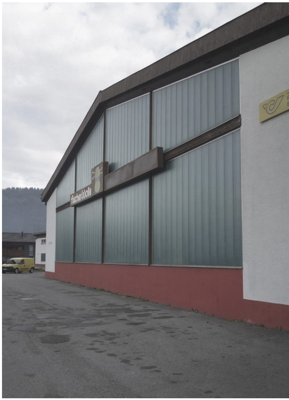
51 Halle 3 | Fassade West
