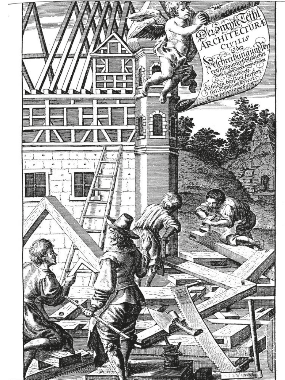
14 Zimmerleute bei der Arbeit. Abbildung aus Johann Wilhelm: Architectura civilis . Frankfurt/Main 1668. Johann Wilhelm stammte aus Bezau im Bregenzerwald und ließ sich später in Frankfurt/Main
