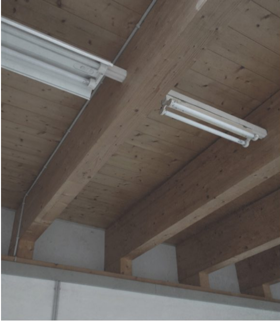
48 Obergeschoss Halle 1 / 2 | Dachstuhl
