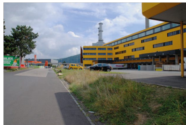
Abb.76: F.11: Potenzialort Ladehof südlich des Baufeldes Synergieeffekte durch kollektive Nutzung derartiger Räume
