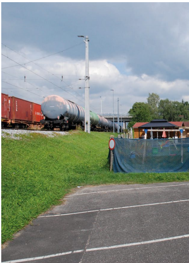
Abb.74: F.08: Nebeneinander von Gleisen und Gärten Möglicher Umschlagplatz von Vollzug auf Güterstraßenbahn
