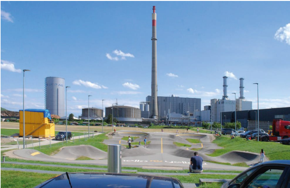
Abb.82: F.13: Blick Richtung Süden auf die Pump-Track-Anlage und das Fernheizkraftwerk Linz Mitte Freizeitanlagen und Versorgungseinrichtungen in einem direkten Nebeneinander
