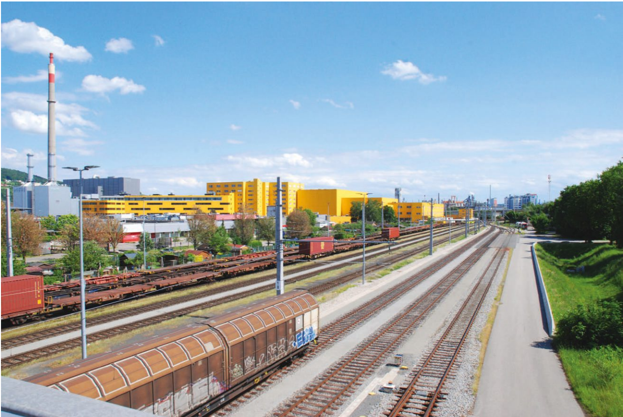
Abb.70: F.04: Verschiebebahnhof Stadthafen, Blick Richtung Süden von der Brücke Prinz-Eugen-Straße Infrastrukturanlagen als Barriere zwischen programmatisch getrenntem Gewerbe- und Wohngebiet
