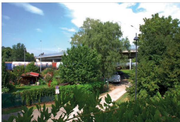
Abb.75: F.10: Blick Richtung Norden auf die Brücke Prinz-Eugen-Str. mit der freien Trasse für die Schleife der Güterstraßenbahn
