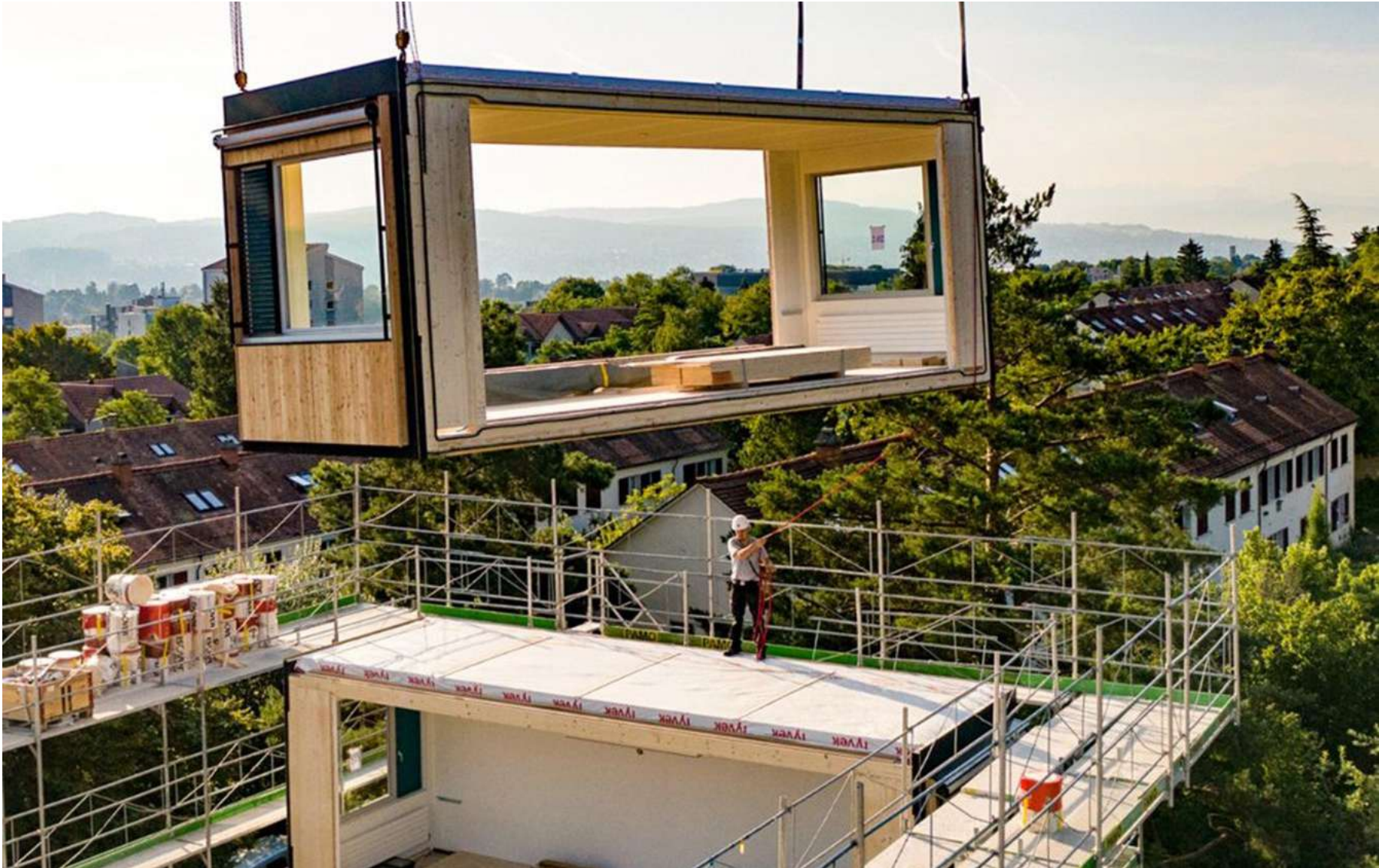
Abbildung 120. Modulares Bauen mit Holz | Modulbau | Holzmodulbau | Holzbau – Lehmann Gruppe
