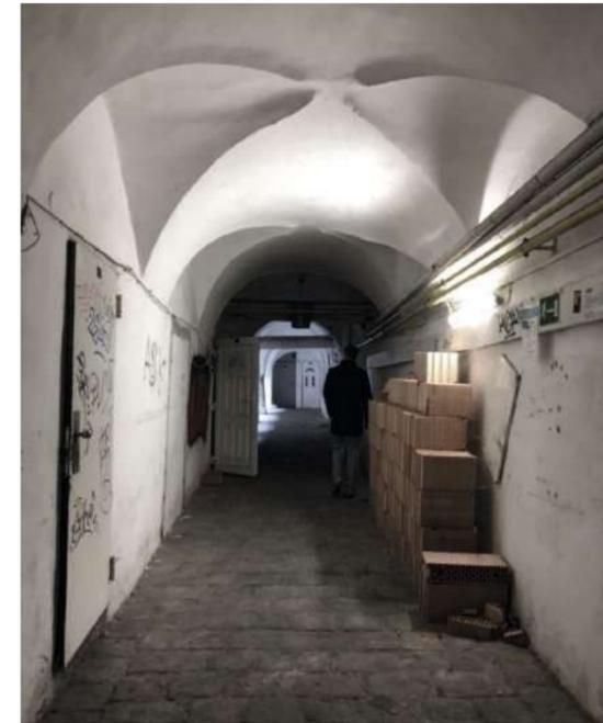
Abb. 65 Raum 0.01, Decke als vierjochiges Kreuzratgewölbe ausgebildet, Boden mit Kopfsteinpflaster belegt ①
