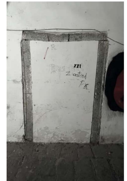
Abb. 68 Raum 0.01, Vermauerte Türöffnung, Umfassung aus Feinkorngranit ④
