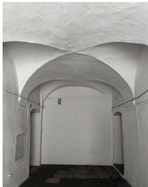
**Abb. 106** Raum 3.02, Kreuzgratgewölbe und Kalksteinplatten, Ergänzungen aus Estrichmörtel, Raum 3.02 kleiner als Raum 2.03, da Teil von dahinter liegendem Top ④
