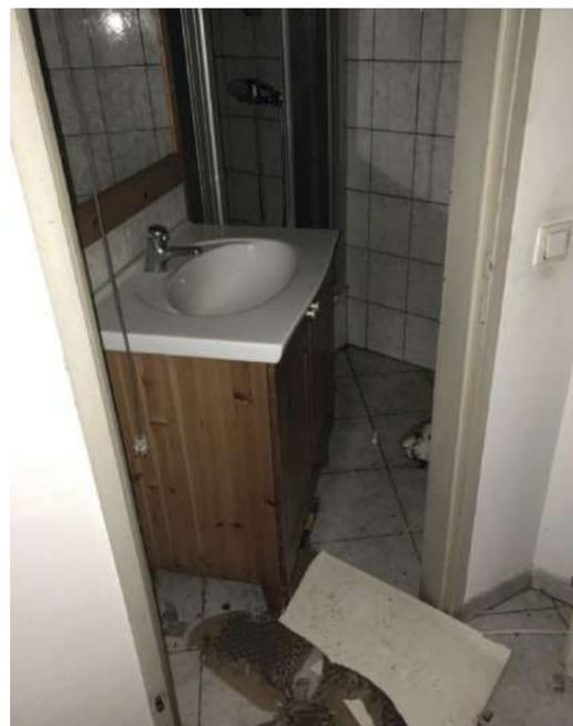
Abb. 114 Raum 3.05, Badezimmereinbauten, keinerlei Mindestmaße eingehalten, Durchgang durch WT versperrt ⑫
