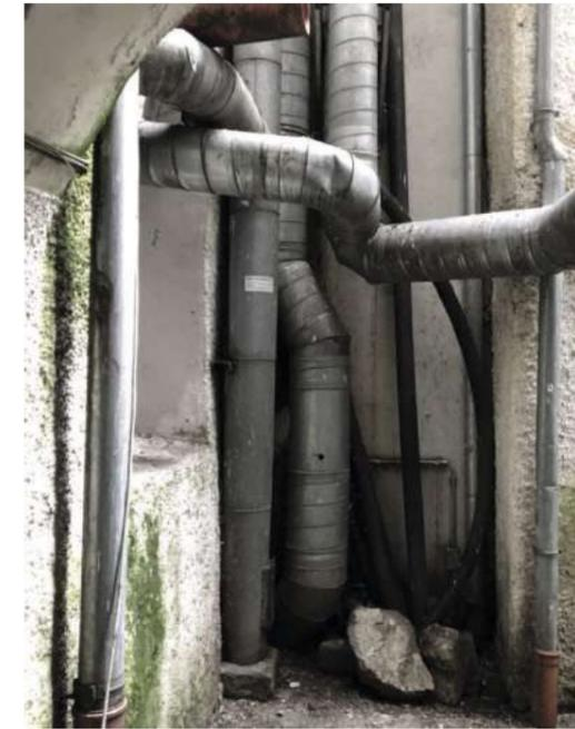
Abb. 71 Hof, Abluftrohre über Dach geführt ⑦
