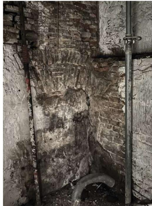
Abb. 69 Raum 0.32, Ziegelmauerwerk aus BP4 auf gewachsenen Fels gemauert ⑤
