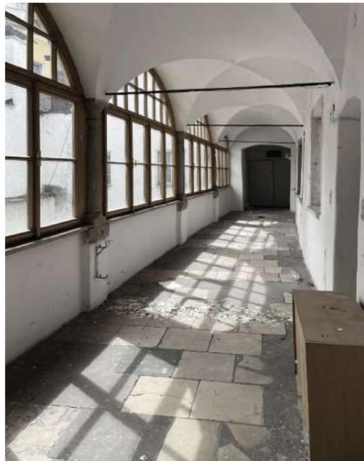
**Abb. 103** Raum 3.18, Arkadengang mit Kreuzgratgewölbe und gegenüber liegenden Stichkappen, quadratischen Kaltsteinplatten und großflächigen Ergänzungen aus Estrichmörtel, niedrigere RH als 1. + 2. OG ①
