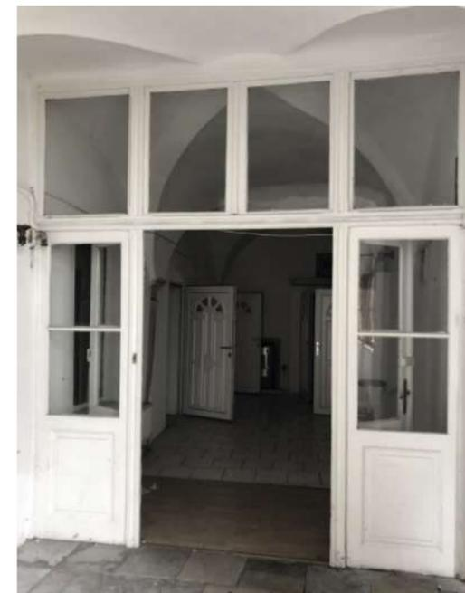
Abb. 91 Raum 2.02, Trennwand zu Raum 2.03, verglaste Holzrahmenkonstruktion, weiß lackiert ③
