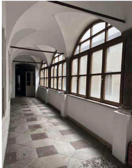
Abb. 78 Raum 1.07, Arkadengang mit Kreuzgratgewölbe und sechseckigen Kaltsteinplatten und quadratischer roten Kalksteinplatte am Boden ①
