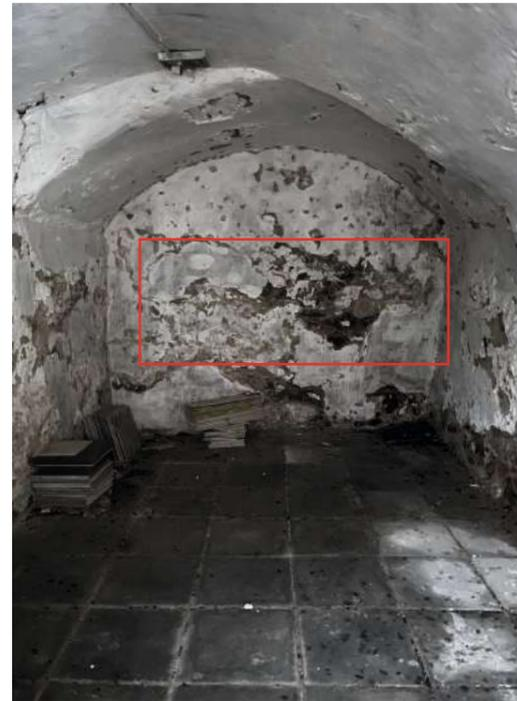
Abb. 70 Raum 0.34, Rückwand Hofhaus weist Bruchsteinmauerwerk auf, vermutlich Trennwand zum Grundstück Hofberg 6 ⑥
