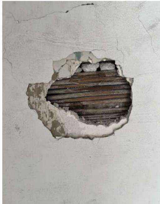
Abb. 111 Raum 3.25, Putzfehlstelle, zahlreiche Farbschichten, Schilfrohrmatte als Putzträger ⑨
