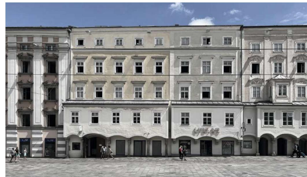
Abb. 25 Fassaden am Hauptplatz, alle mit ausgebauten Geschossen hinter Vorschussmauer
