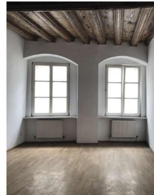
**Abb. 95** Raum 2.09, Außenwand zum Hofberg, Parkettboden aus BP5, Balkendecke und Unterzug, abgefaste Balken (BP2) ⑥
