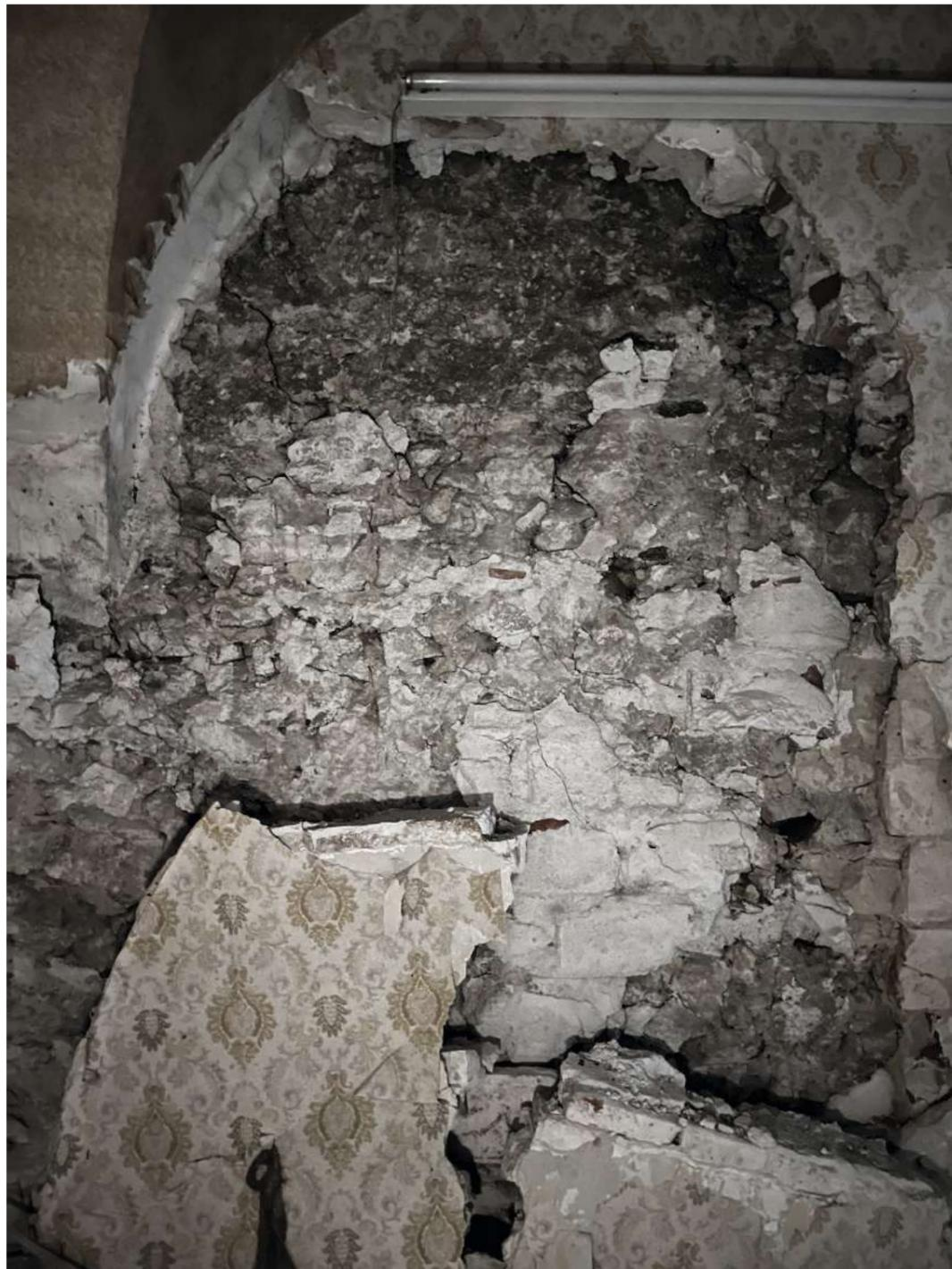
Abb. 84 Raum 1.06, Außenwand zum Nachbarhaus Hofberg 6, Ziegelwand aus BP3 vor Bruchsteinmauerwerk aus BP1 (8)
