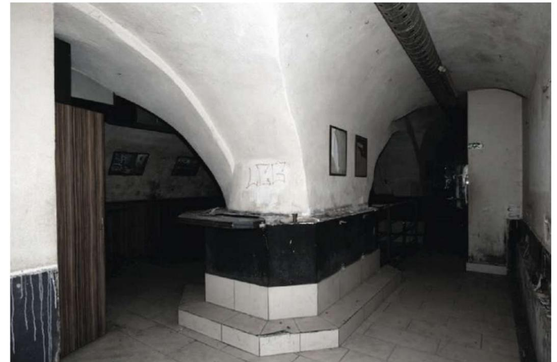
Abb. 60 Raum K.01, Pfeiler tragen eine Trennwand, die bis in das 3.OG verläuft ①
