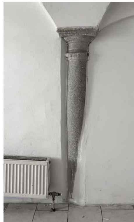
Abb. 38 Indiez für Stiegenhausumbau: Säule zur Gewichtsaufnahme im 2.OG zeugt von einer ursprünglich großen offenen Halle im Vorderhaus
