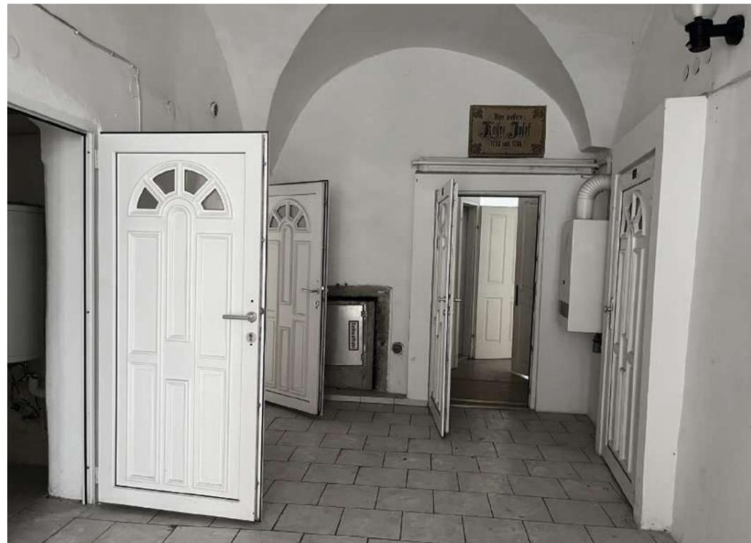
**Abb. 93** Raum 2.03, Kreuzgratgewölbe und neue keramische Fliesen, vermutlich über Kalksteinplatten verlegt, da erhöhtes Niveau zum Arkadengang, neue Kunststoff Eingangstüren, Gedenktafel an Beherbergung von Kaiser Josef in den Jahren 1783 und 1786 ④
