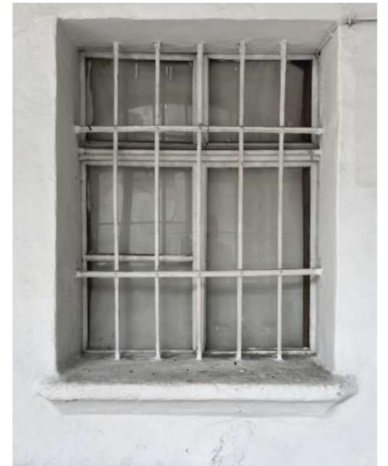
**Abb. 108** Raum 3.18, F5 ohne sichtbare Umrahmung, evtl. unter Putz, vermauertes Gitter, Fensterbank aus Feinkorngranit, weiß überstrichen ⑥
