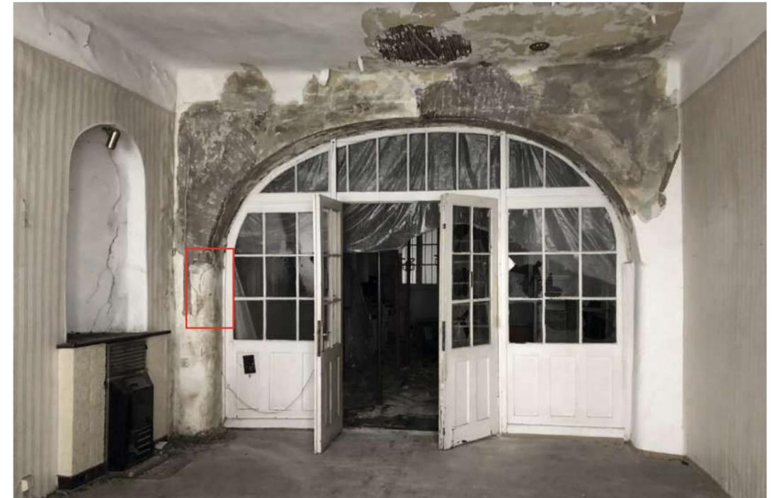
Abb. 82 Raum 1.04, Richtung Raum 1.03, verglaste Holzrahmenkonstruktion mit fest verbauten Seitenteilen und Oberlicht mit Sprossenteilung, sowie zweiflügeliger verglasteter Tür, weiß lackiert; 2.H. 19. Jh. ⑤
