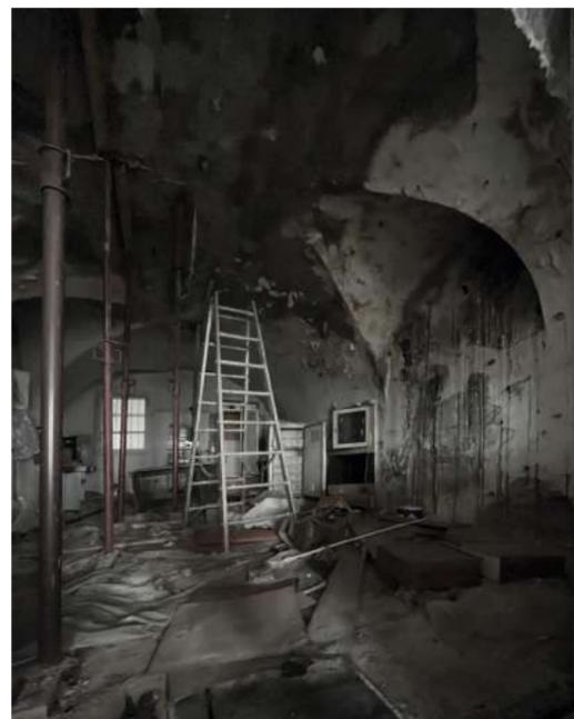
Abb. 44 Einsturz des Gewölbes im 3. OG durch unsachgemäße Verlegung von Wasser- und Gasleitungen
