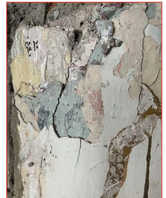
Abb. 82 rangezoomt, zahlreiche Farb- und Tapetenschichten, untere Schichten in Grün- und Rottönen ⑦
