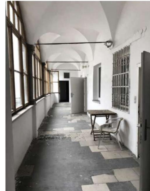
Abb. 89 Raum 2.20, Arkadengang mit Kreuzgratgewölbe und versetzten Stichkappen, quadratische Kaltsteinplatten und großflächige Ergänzungen aus Estrichmörtel, Außenwand zum Hof ursprünglich offen ①
