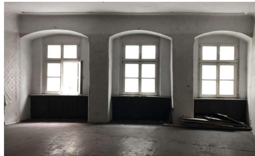
Abb. 87 Raum 1.05, Außenwand zur Gasse am Hofberg, drei segmentbogige Fensternischen, zweiflügelige Kastenfenster, mit mittigen Quersprossen und Oberlichtern, Brüstungsverkleidung aus Holz (11)
