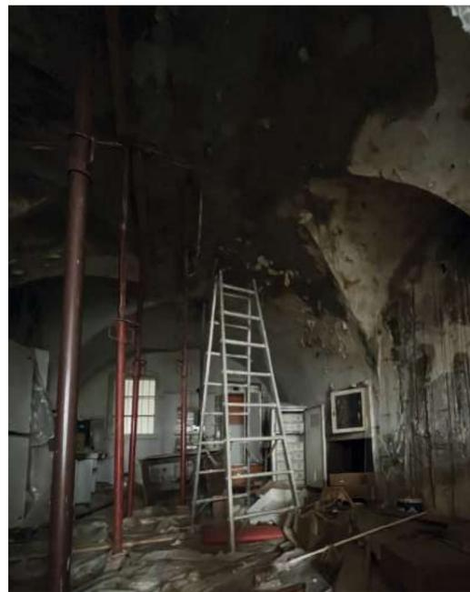
Abb. 81 Raum 1.03, Tonnengewölbe verputzt und getüncht; wegen Wassereintruchs und statischen Schäden durch Pfosten abgestützt. (Foto aufgehellt) ④
