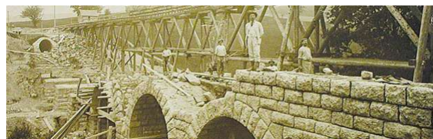
ABB. 14: AUSBAU DER WASSERVERSORGUNG WIENS
