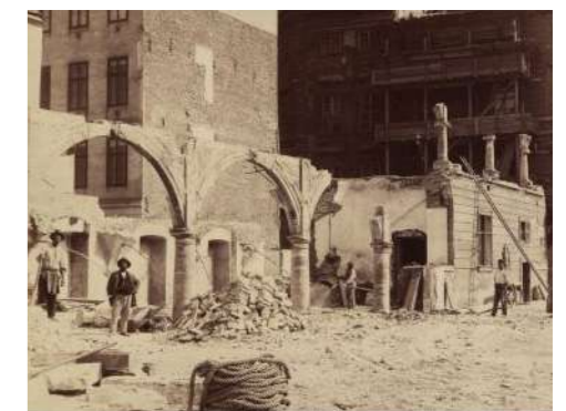
ABB. 20: WIEDERAUFBAU VON EINEM KRANKENHAUS
