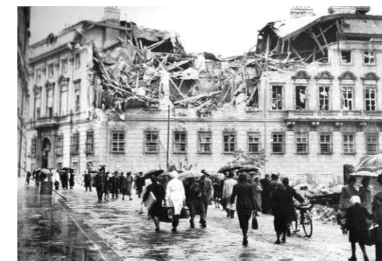
ABB. 19: GEBÄUDE NACH BOMBENEINWIRKUNG
