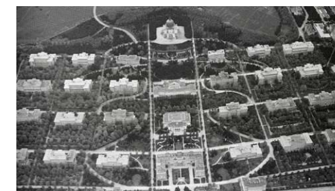
ABB. 16: VERSORGUNGSHAUS OTTO - WAGNER - SPITAL
