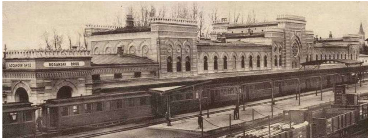
Abb. 67 - Bahnhofsgebäude in Bosanski Brod, bahnseits, Postkarte, 1910
