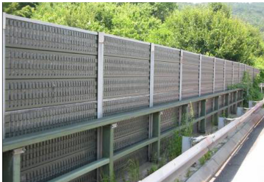
Abbildung 44 : Lärmschutzwand aus Kunststoff [27]
