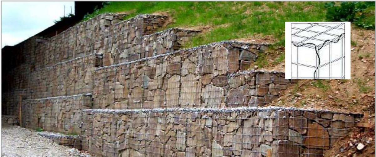
Abbildung 43 : Lärmschutzwand mit gefüllten Körben [33]
