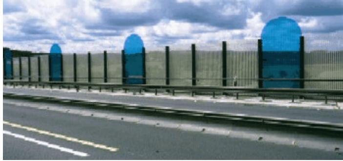
Abbildung 45 : Lärmschutzwand aus transparenten Materialien [40]
