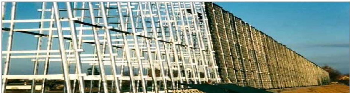
Abbildung 20 : Lärmschutzwall System Aquasol KNL im Bau [33]
