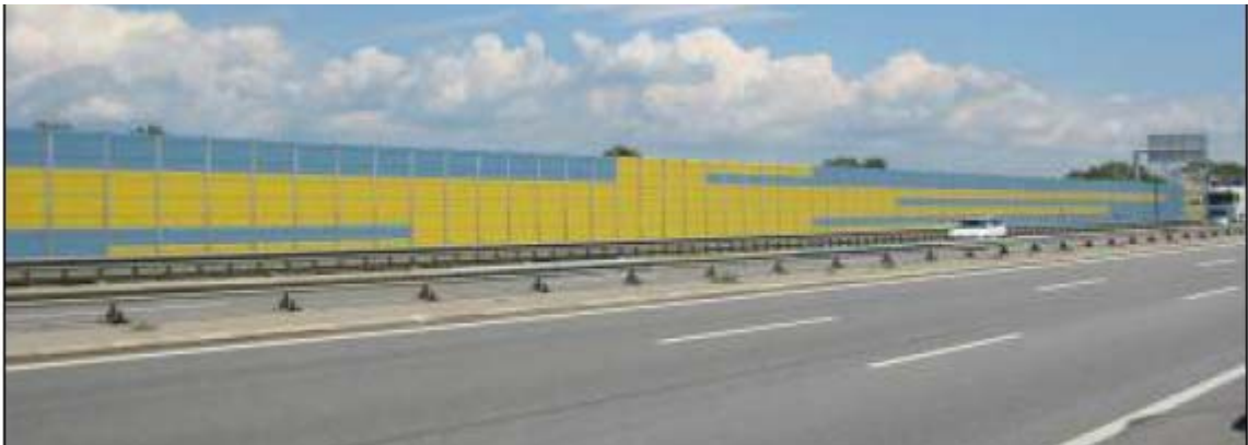
Abbildung 37 : A1 West- Autobahn bei St. Pölten, Richtung Salzburg [27]
