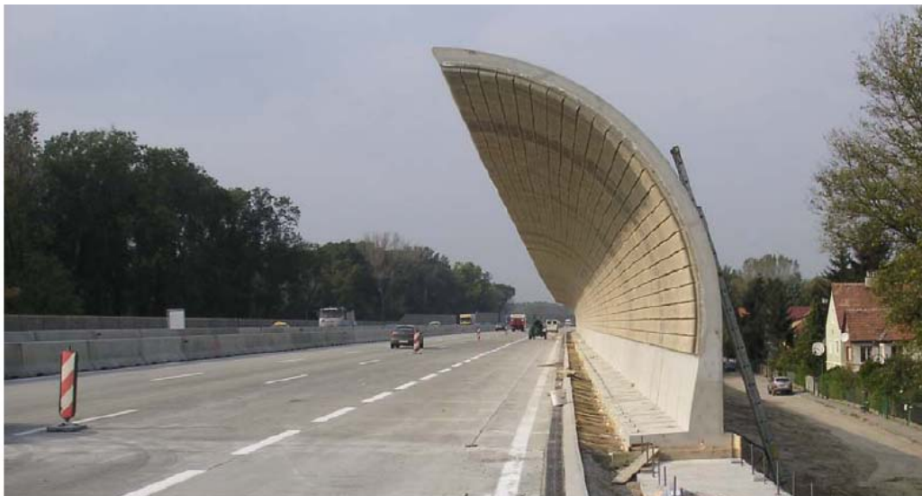
Abbildung 29 : Gekrümmte Wand an der A22 Donauufer- Autobahn bei Korneuburg [27]
