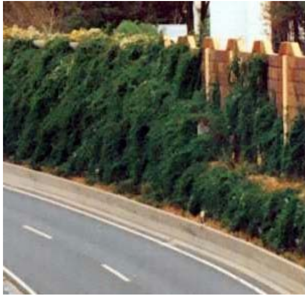
Abbildung 24 : Begrünter Steilwall „Greenwall“ [34]
