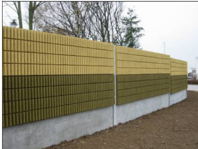
Abbildung 41 : Lärmschutzwand aus Beton [27]
