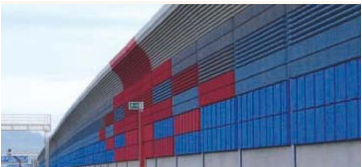
Abbildung 31 : Kleiner Bogen an der A1 West- Autobahn bei Salzburg- Taxham [35]
