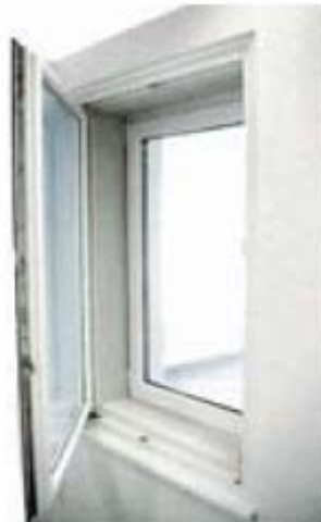
Abbildung 47 : Fenster- Vorsatzschale (Kastenfenster) [10]
