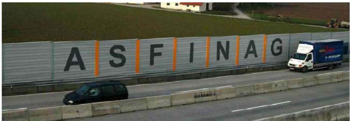
Abbildung 42 : Lärmschutzwand aus Aluminium [27]
