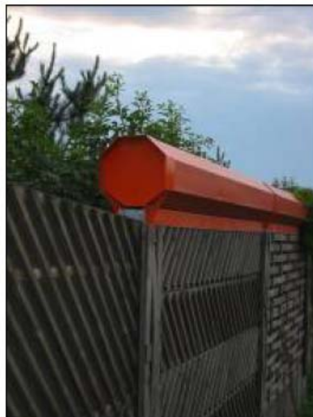
Abbildung 33 : Lärmschutzwandaufsatz „Octagon“ [27]
