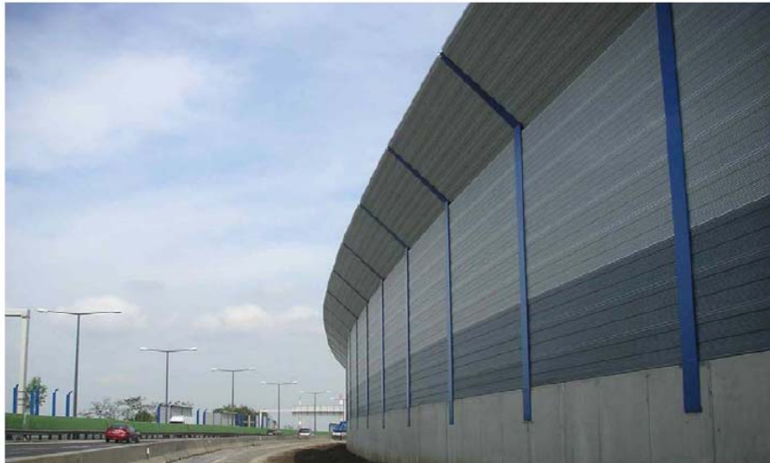
Abbildung 32 : A23 Südosttangente; Abgewinkelte Lärmschutzwand [27]
