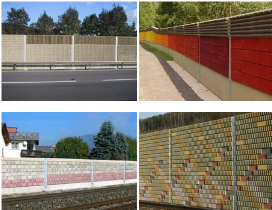
Abbildung 38a : Bausteinsystem der Firma Durisol [38]
