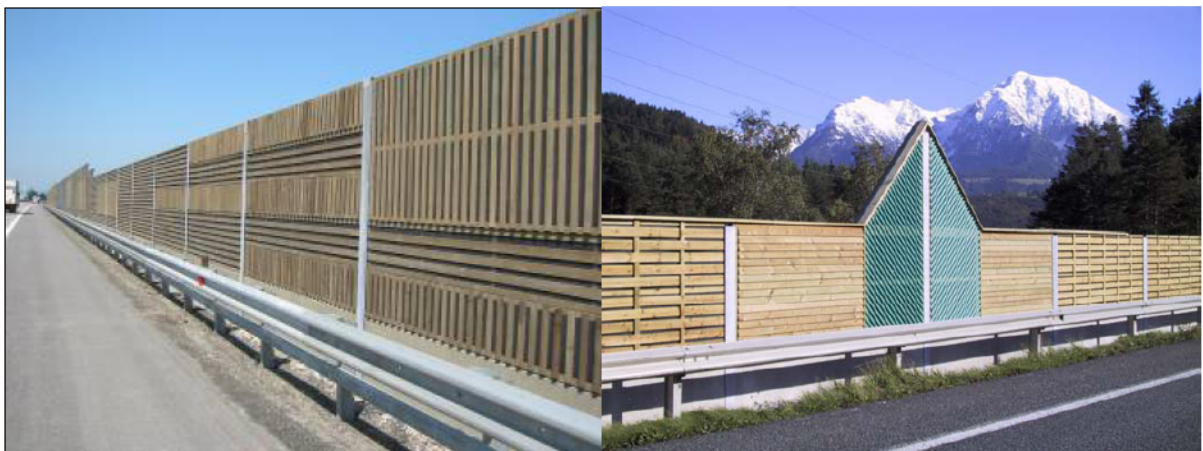
Abbildung 40 : Lärmschutzwand aus Holz [27]
