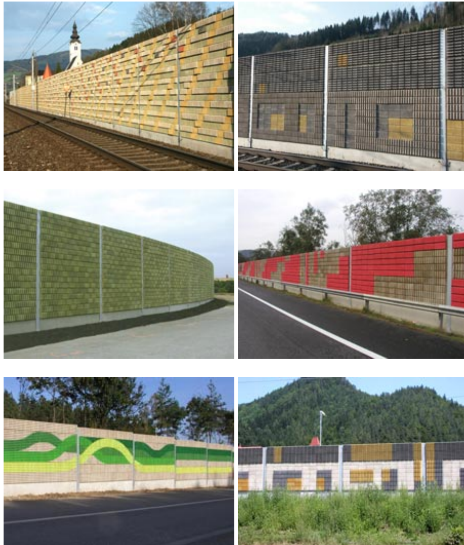
Abbildung 38b : Bausteinsystem der Firma Durisol [38]
