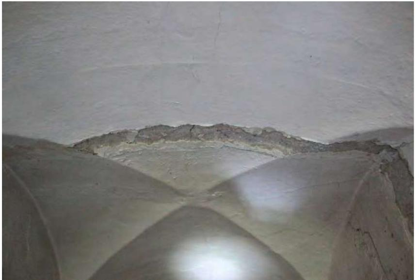
**Gewölbe: Einbau früherer Trennwand erkennbar**
