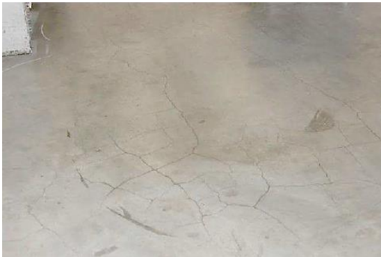
Abbildung 1 Netzrisse im Estrich [22]
