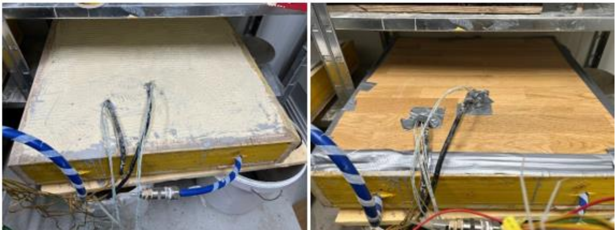
Abbildung 30 Estrichplatte mit vollflächiger Klebemasse und nach Parkettverlegung
