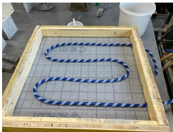
Abbildung 15 Schalung mit eingelegten Heizungsrohren
