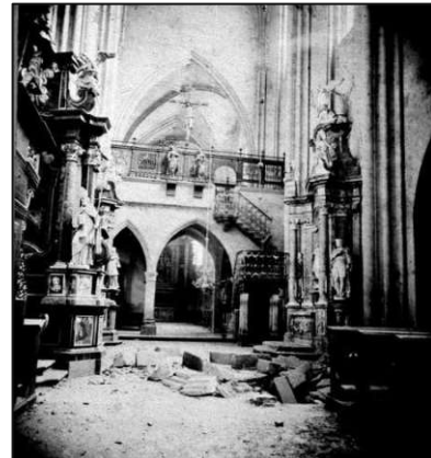
Abbildung 4: Erdbebenschäden im Zagreber Dom nach dem Erdbeben im Jahr 1880. Foto: Ivan Standl
