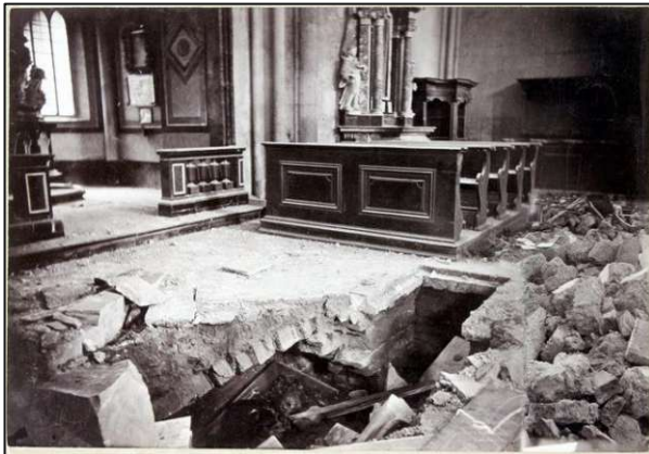
Abbildung 3: Durchbrochener Boden im Zagreber Dom nach dem Erdbeben im Jahr 1880. Foto: Ivan Standl
