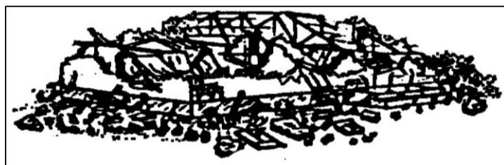
Abbildung 23: Schadensgrad 5 nach der EMS-98 [7].
