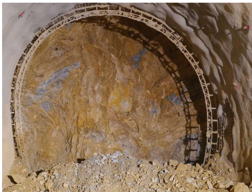
Abb. 2.10: Tunnelbogen (Quelle: Tappauf.consultants [43])
