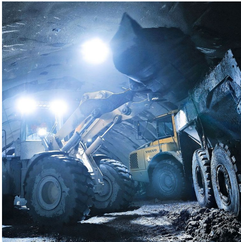
Abb. 2.7: Gerätedisposition für einen Schuttervorgang (Quelle: ÖBB [29])
