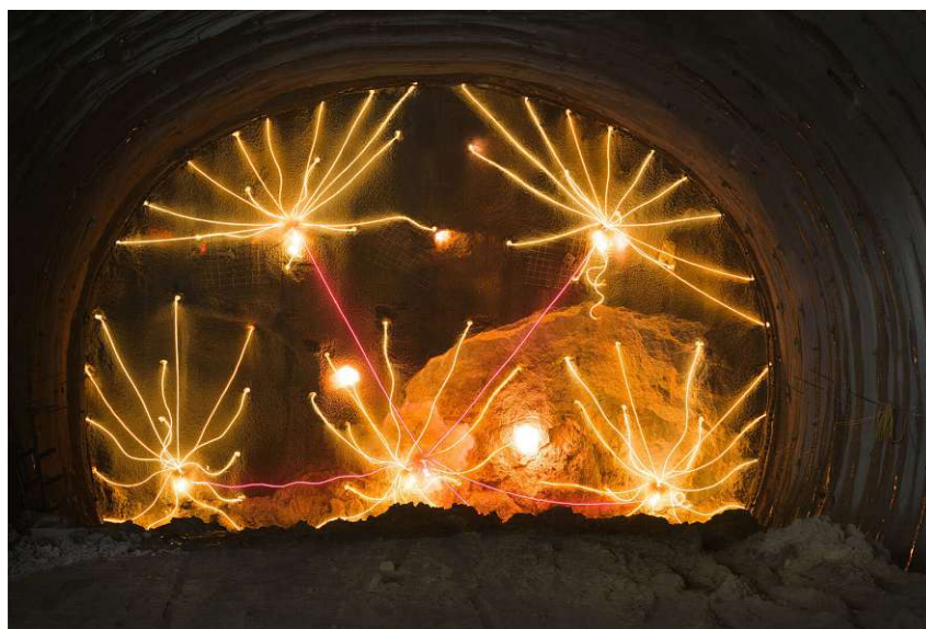
Abb. 2.4: Sprengung (Quelle: ÖBB [30])
