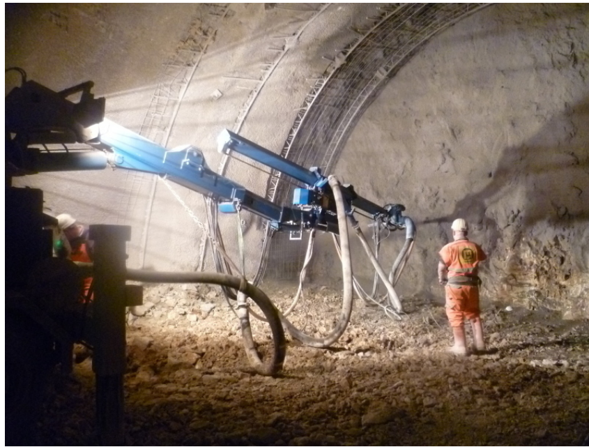
Abb. 2.8: Nassspritzverfahren mittels Spritzroboter an der Ortsbrust (Quelle: Tunnel-Online [45])
