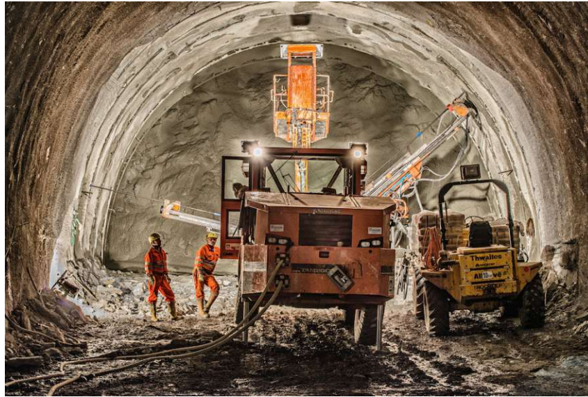
Abb. 2.9: Einbringen von Mehrfachanker im Bereich der Tunnellaibung (Quelle: GKI [15])
