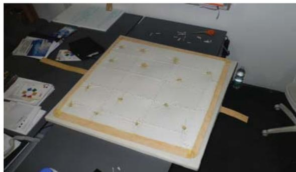
Diese wird mit einer weiteren gummierten Stofflage abgedeckt. Abschließend werden die Mikroporen mit Nadeln erzeugt und die Abstandhalter zwischen erster und zweiter Dämmlage aufgebracht.
