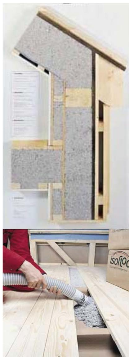
Abb.14 Cellulose Einblasdämmung
