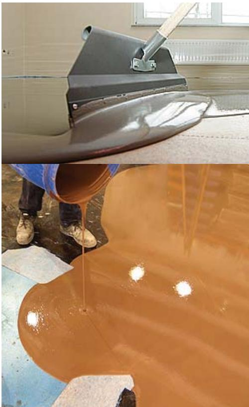
Abb.34 Selbstnivellierende Ausgleichsmassen
