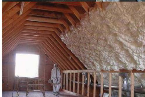
Abb.58 Auftragen von PUR Spritzschaum
