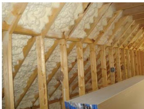
Abb.57 Dachschrägenanwendung Soytherm
