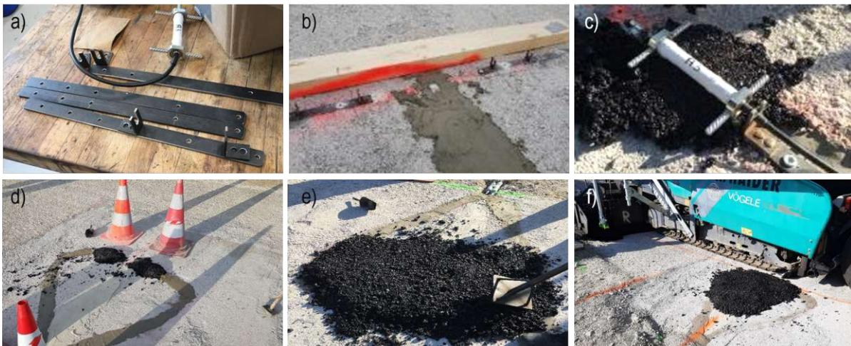
Abb. 2.11: Einbau nach Methode B
