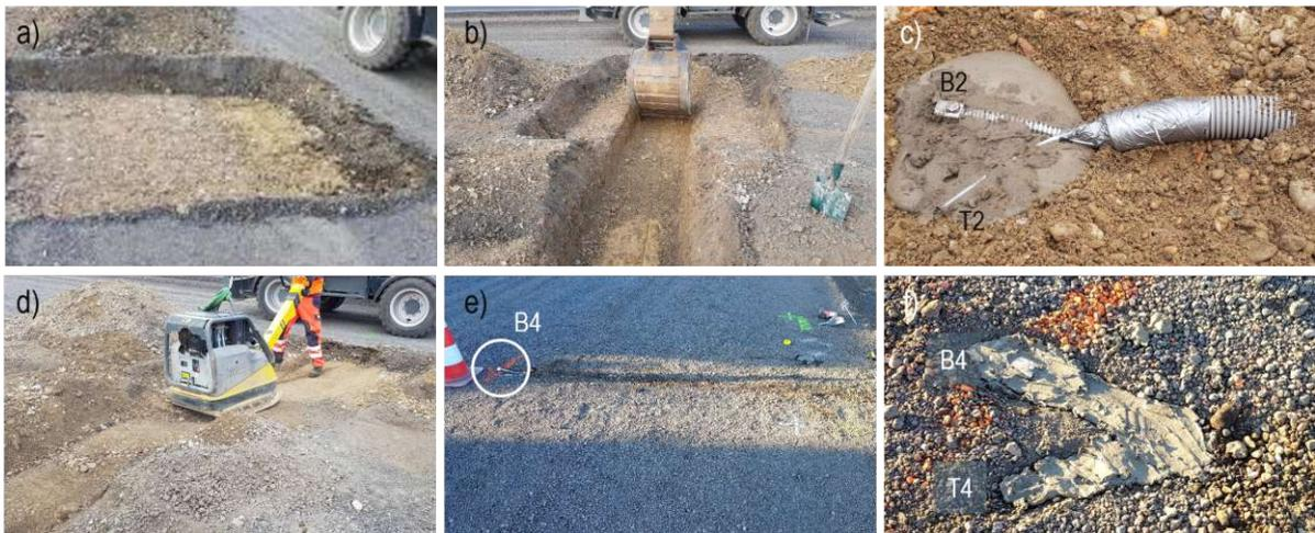
**Abb. 2.6:** a. Aushub der o.TS, b. Aushub der u.TS, c. Einbau an der UK der u.TS, d. Verdichtung der beiden TS, e. & f. Einbau an der OK der o.TS
