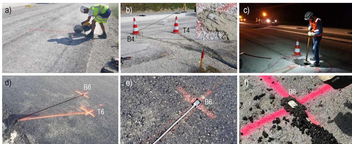
Abb. 2.8: a., d. & e. Fräsen des Kabelkanals, b. & f. Einbau und Verfüllung der Sensoren, c. händische Verdichtung
