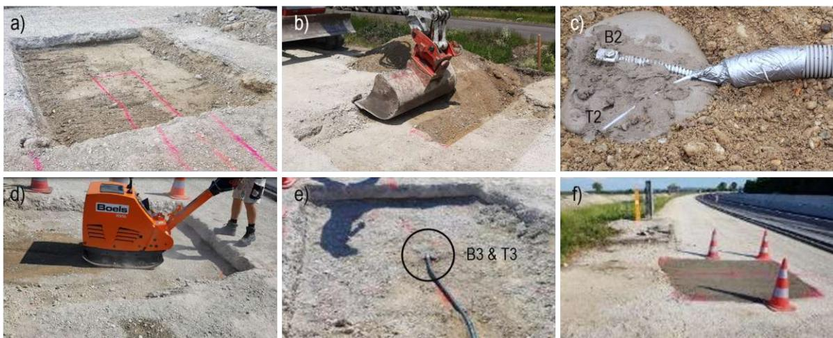
**Abb. 2.7:** a. Aushub der o.TS, b. Aushub der u.TS, c. Einbau an der UK der u.TS, d. Verdichtung der u.TS, e. Einbau an der OK der u.TS, f. Füllung mit Magerbeton
