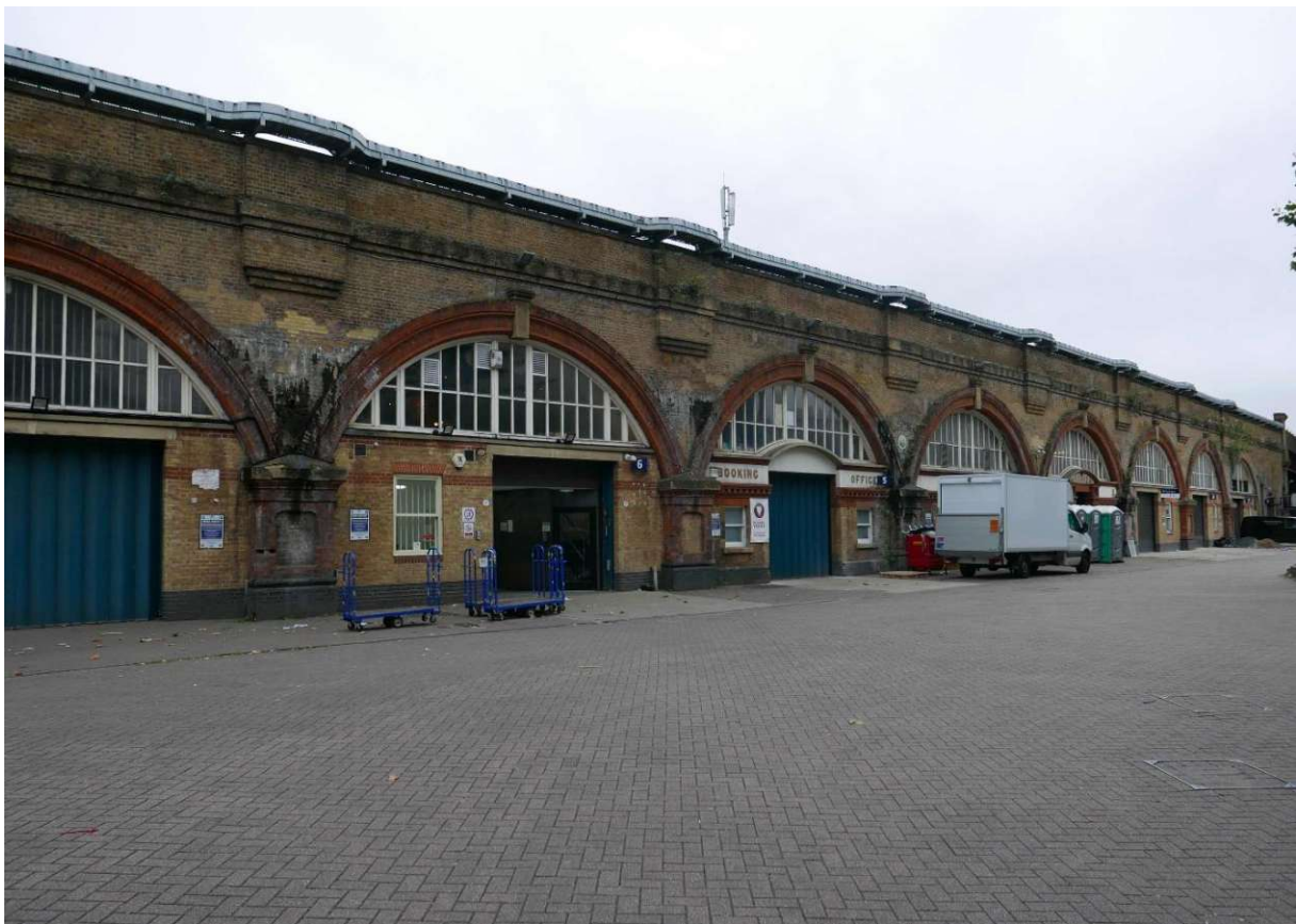
Abbildung 2 Viadukt der London Greenwich Railway heute
