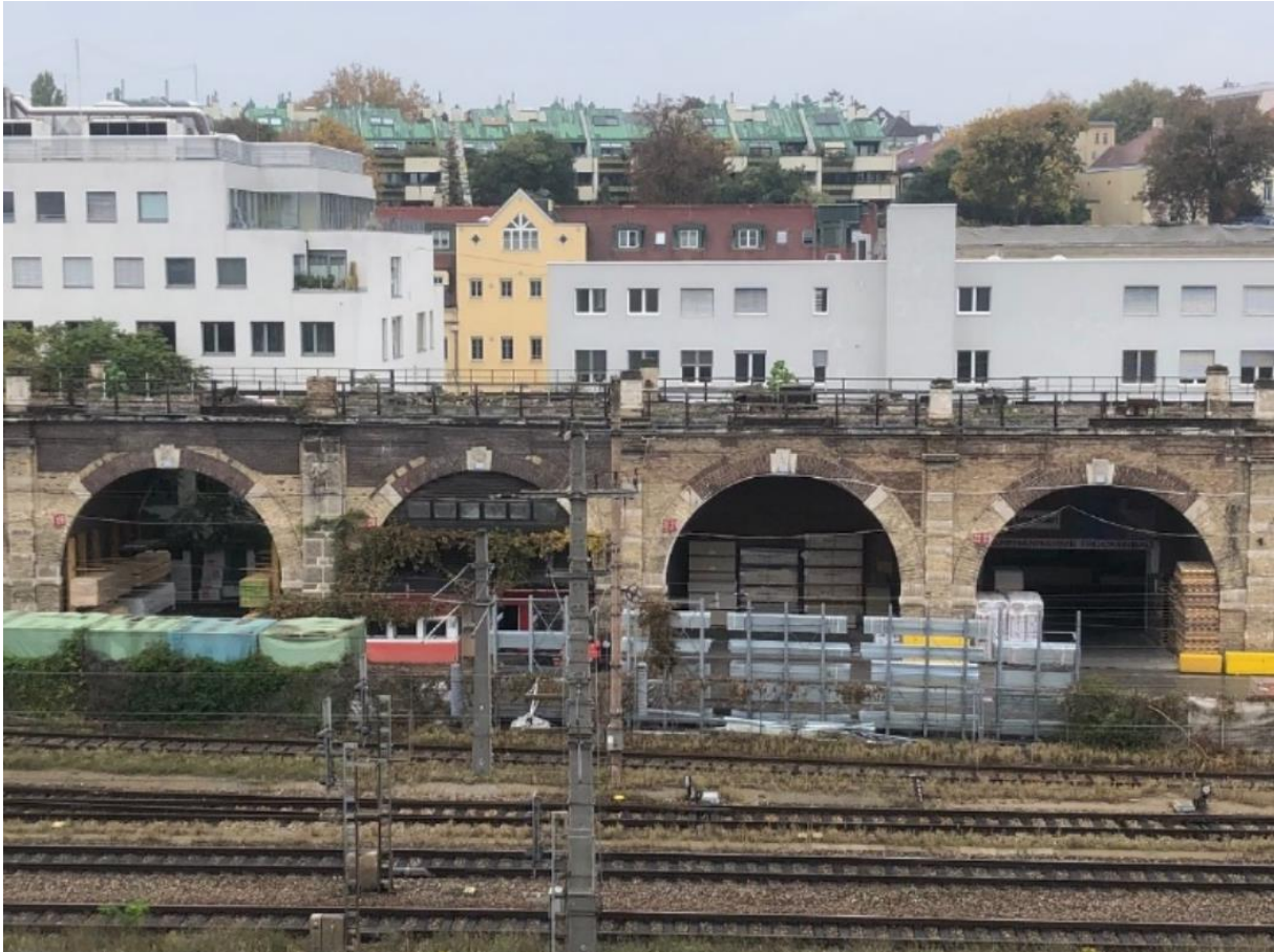
Abbildung 74 Viaduktbögen in Heiligenstadt: im unteren Bereich sind die gelben, originalen Verblendziegel noch erhalten
