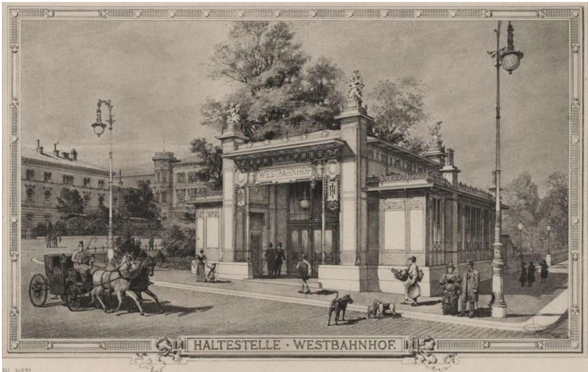
Abbildung 42 Stadtbahnstation Westbahnhof eingebettet in das Wiener Alltagsleben
