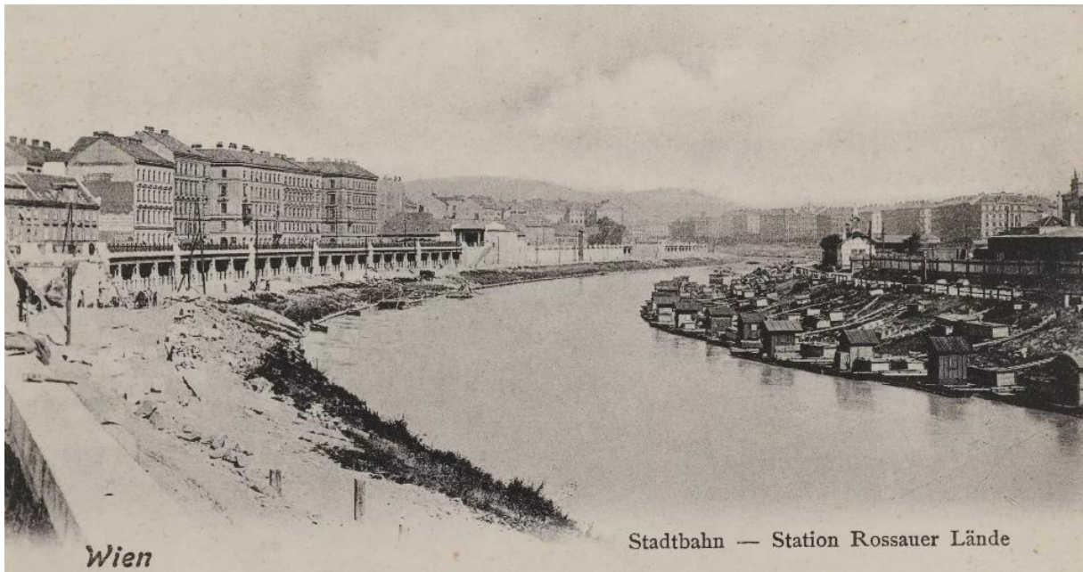
Abbildung 70 Der Bau der Galerie an der Rossauer Lände
