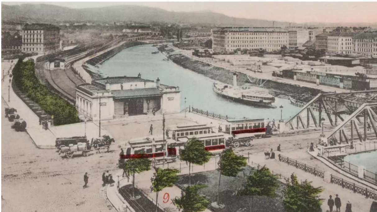
Abbildung 121 Foto Station Brigittabrücke um 1900
