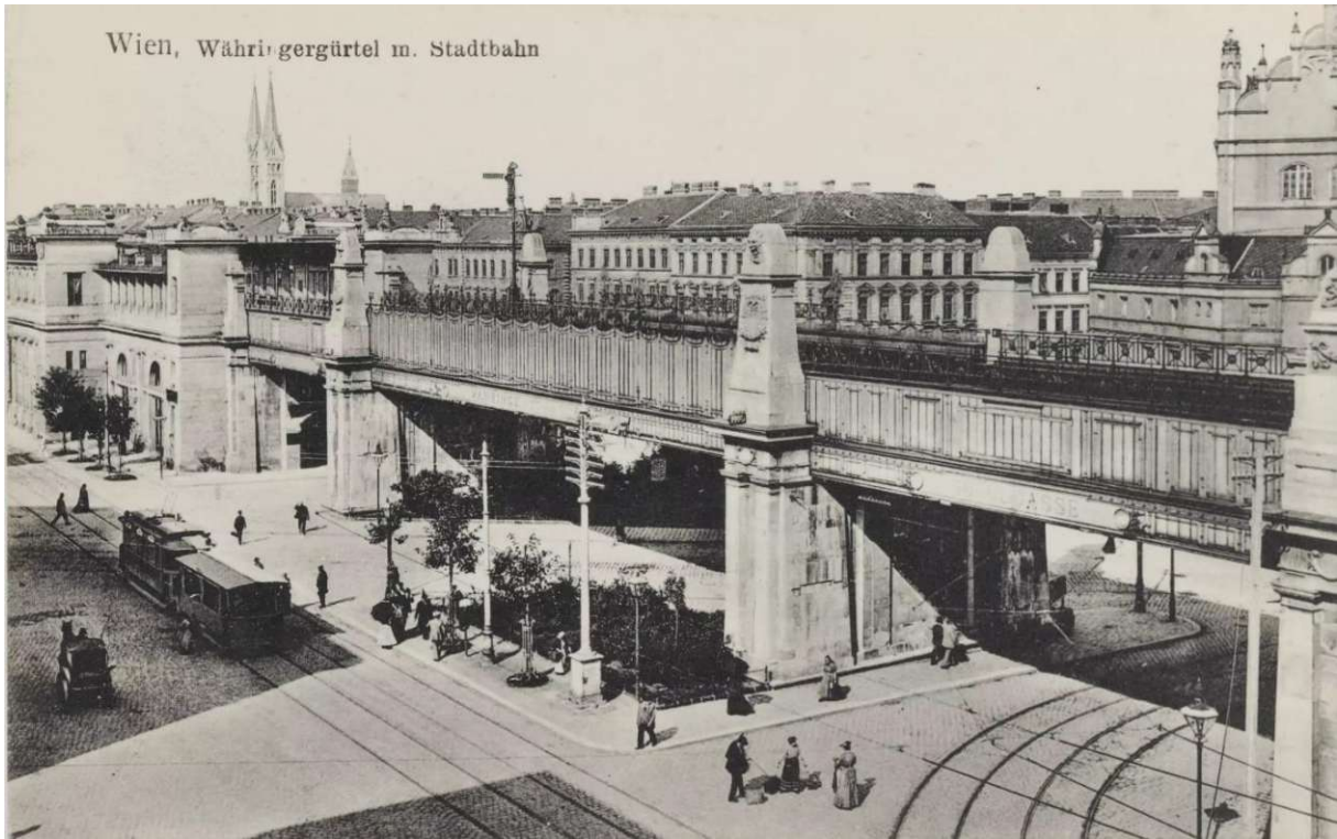
Abbildung 51 Brücke über Währinger Straße, 1912
