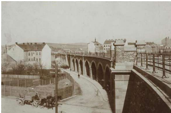
Abbildung 48 Viaduktbögen in Ottakring
