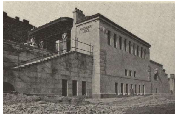
Abbildung 38 schlichte ornamentale Ausgestaltung der Fassade der Station Rossauer Lände aus dem Jahr 1901
