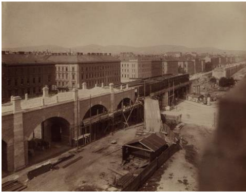
Abbildung 56 Bau der Stadtbahn zwischen 9. und 18. Bezirk
