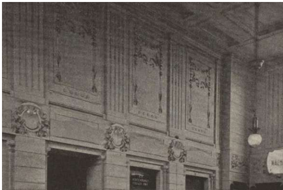
Abbildung 37 Florales Ornament in der Station Hütteldorf, Fertigstellung 1896
