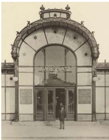
Abbildung 59 Station Karlsplatz um 1900 mit dunklen Metallelementen
