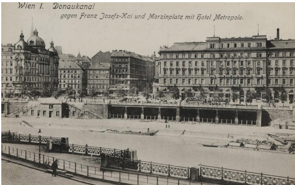
Abbildung 71 Die fertige Strecke am Schwedenplatz
