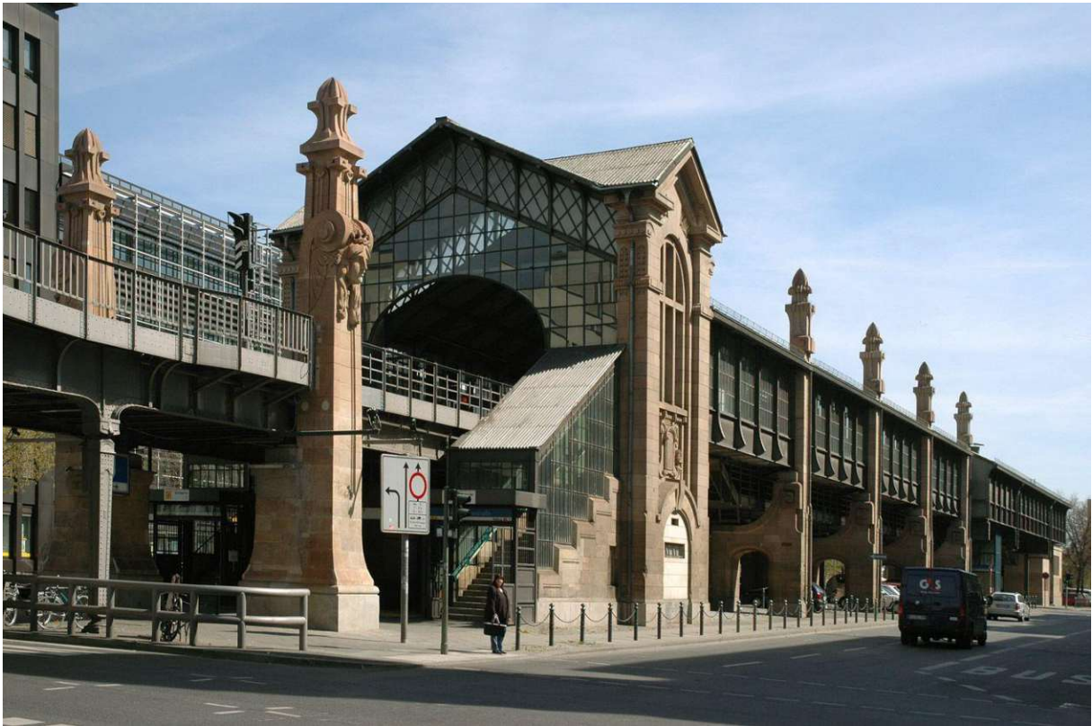
Abbildung 6 Berliner U-Bahnstation Bülowstraße als Hochstation
