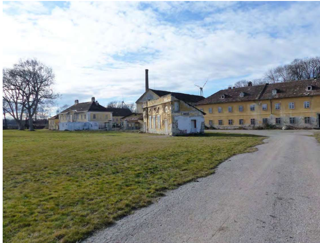
Abbildung 16: Blick von Osten auf das Ensemble, 06.02.2020
