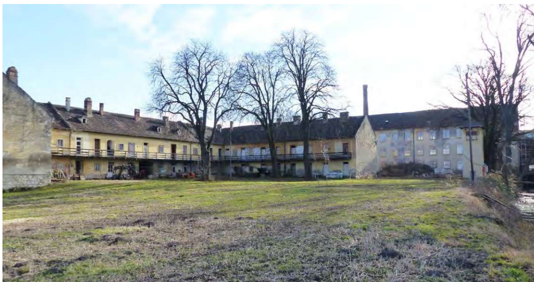
Abbildung 12: Blick aus Nordwesten auf das Arbeiterwohnhaus, 06.02.2020
