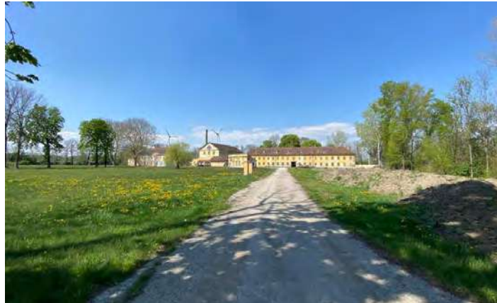
Abbildung 6: Blick von der Einfahrt nach Westen auf das Objekt
