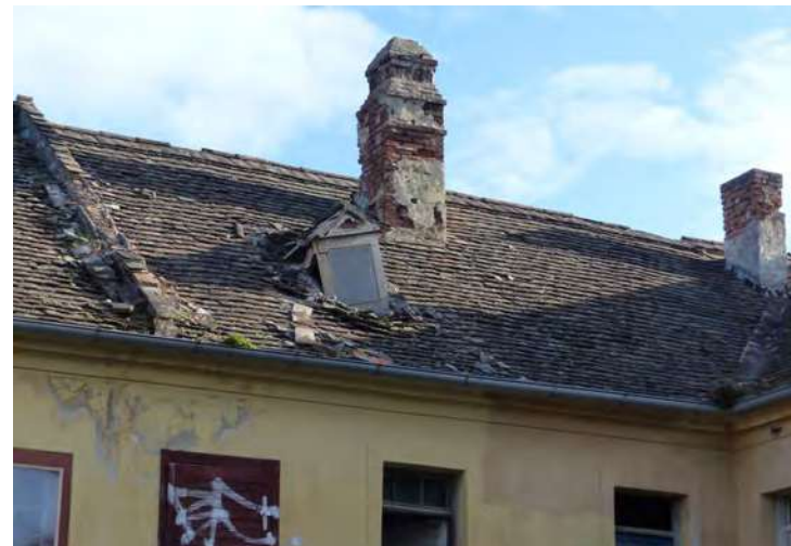
Abbildung 66: Dachgaube auf der rechten Seite des Arbeiterwohnhauses, 06.02.2020
