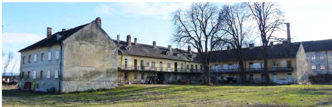
Abbildung 24: Westfassade und Nordfassade Arbeiterwohnhaus, 06.02.2020
