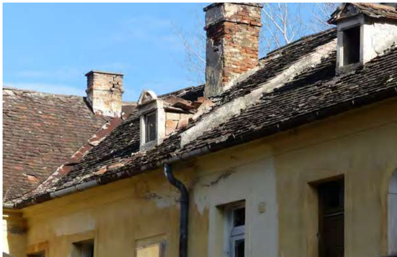
Abbildung 65: Dachgaube auf der linken Seite des Arbeiterwohnhauses, 06.02.2020
