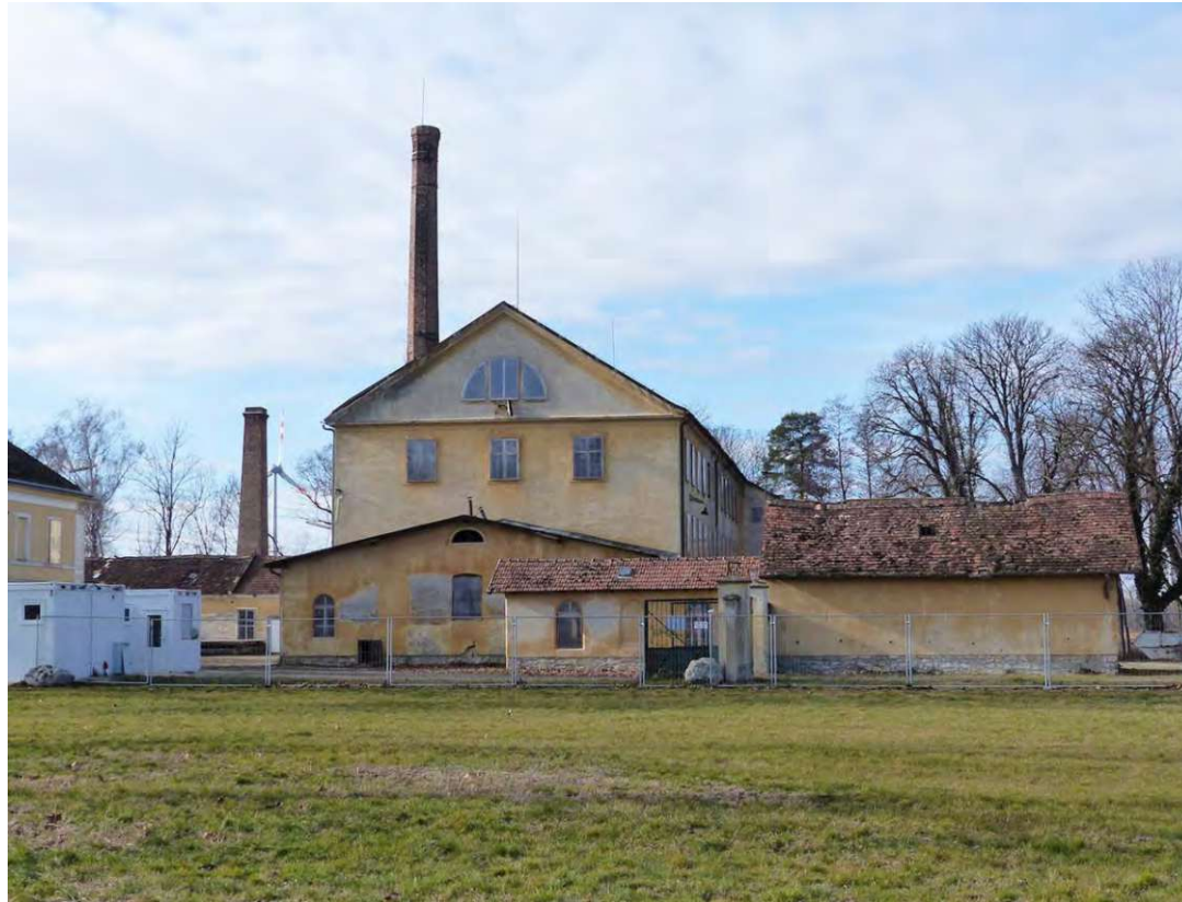
Abbildung 10: Blick von Osten auf das Ensemble, 06.02.2020
