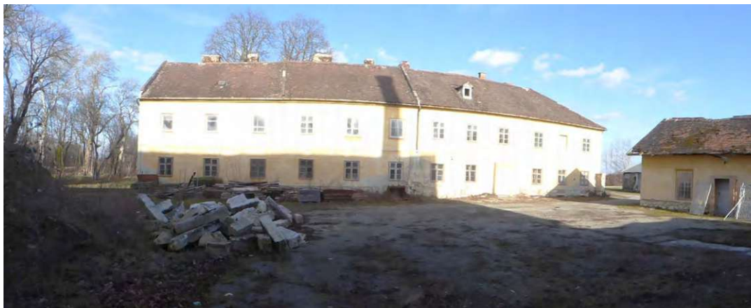
Abbildung 11: Blick von Süden auf das Arbeiterwohnhaus, 06.02.2020
