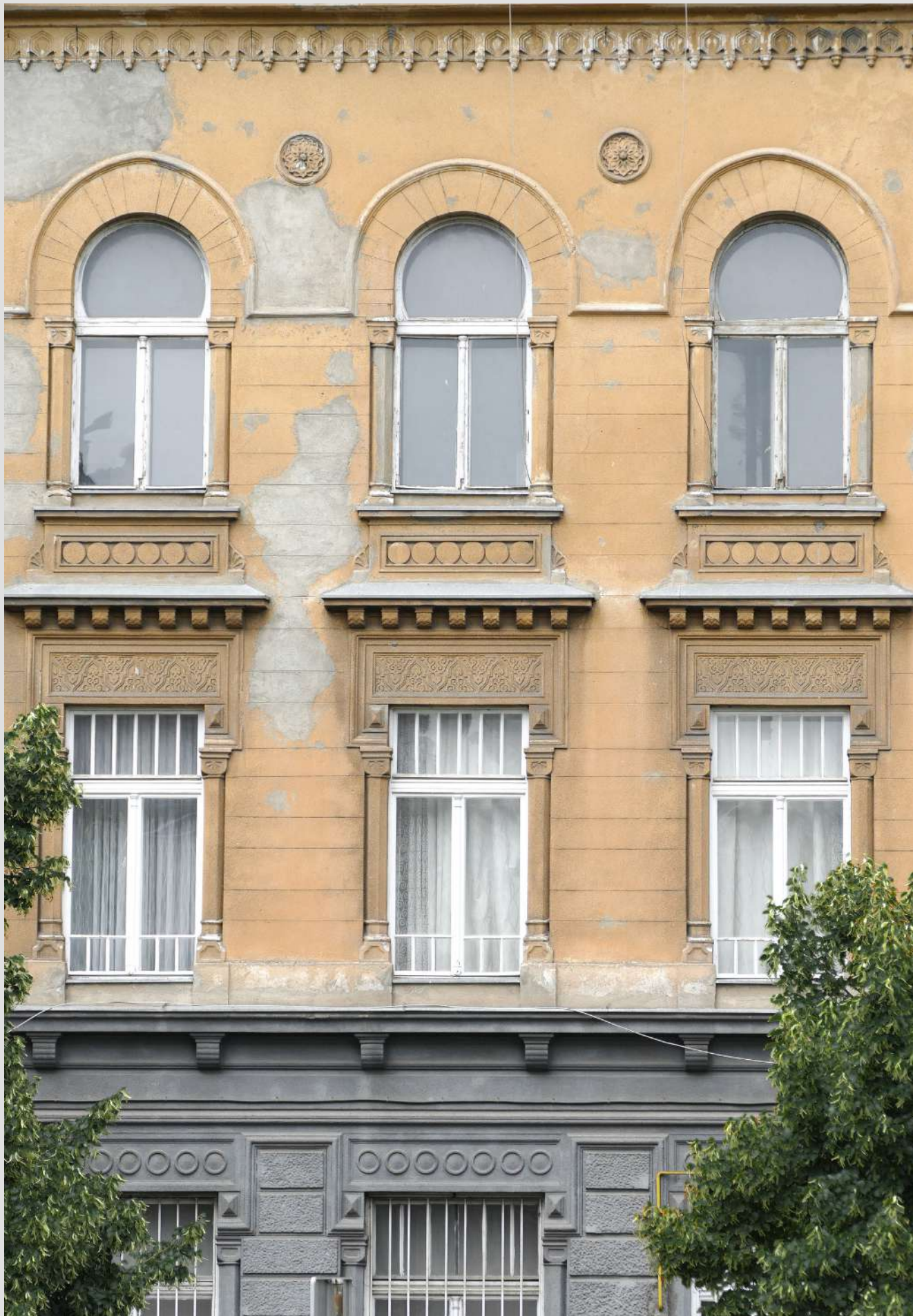
Abb. 162: Detail Nordfassade, Juli 2022
