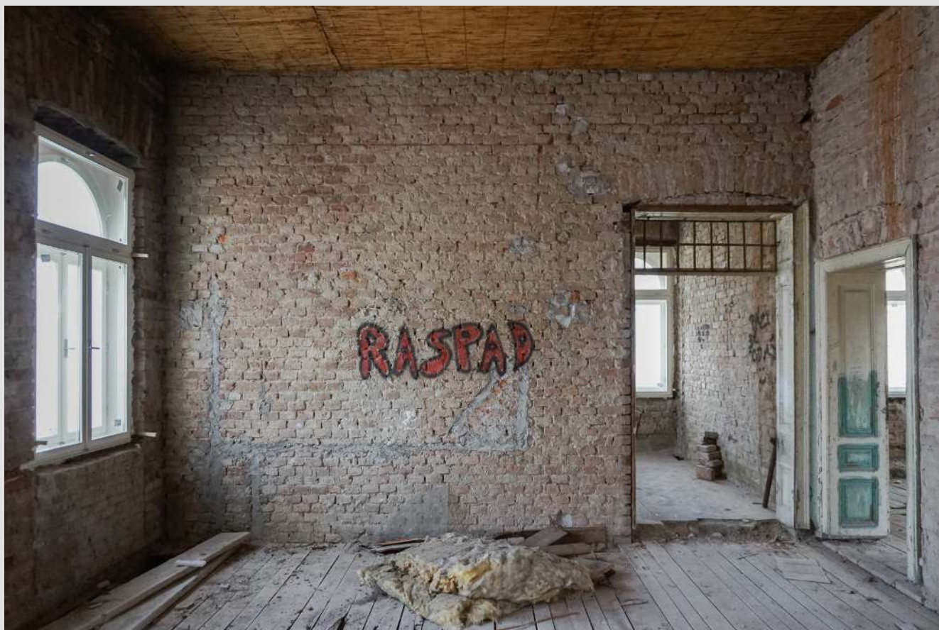
links: Abb. 119. Zugang zum Obergeschoß, Juni 2022
