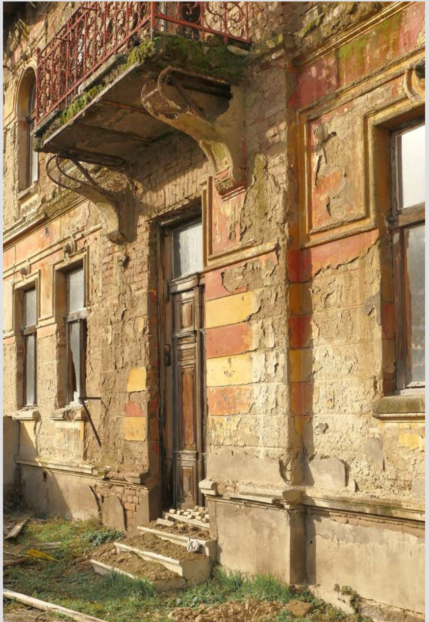
Abb. 95: Südostfassade, Eingangssituation, Jänner 2022
