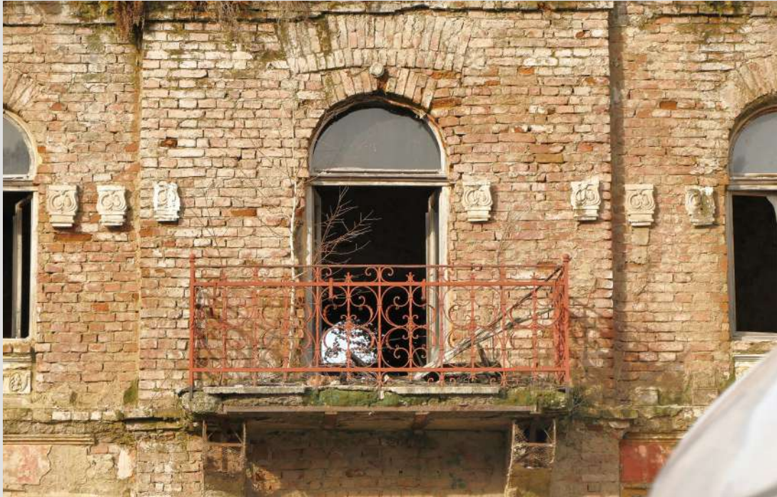
Abb. 98: Südostfassade, Balkon und Mittelrisalit
