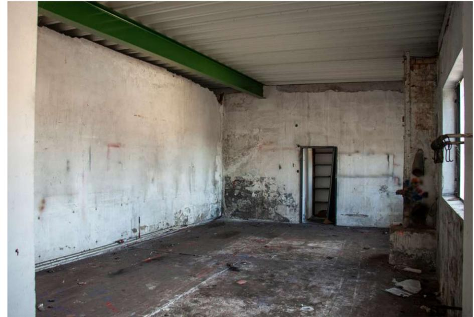
Abb. 104: Obergeschoß mit nachträglich eingebautem Trapezblech
