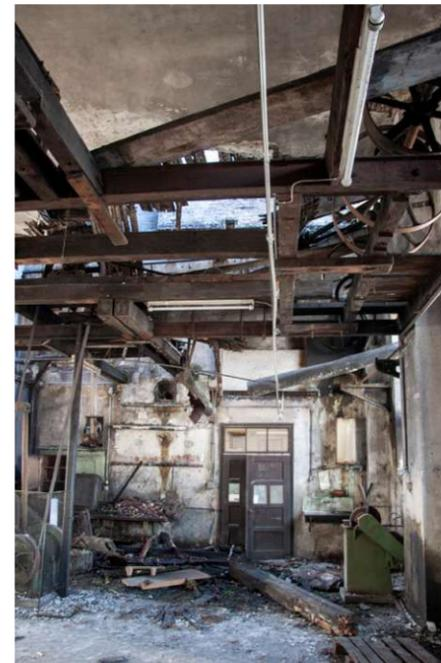
Abb. 74: Haupthalle mit eingestürztem Dachstuhl
