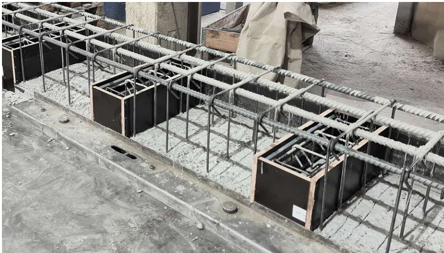
Abbildung B.4: Herstellung Versuchskörper K. Platte betoniert. Querbalken geschalt. Bewehrung verlegt.
