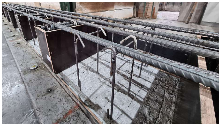
Abbildung B.5: Herstellung Versuchskörper N. Platte betoniert. Querbalken geschalt. Bewehrung verlegt.
