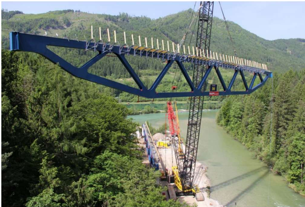
Abbildung 3.1: Teichlbrücke - Einheben mittels Mobilkran. Bildquelle: [14]
