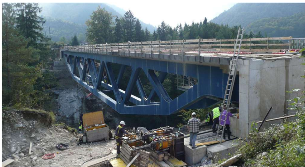
Abbildung 3.4: Teichlbrücke – Querverschub (von rechts nach links). Bildquelle: [18]
