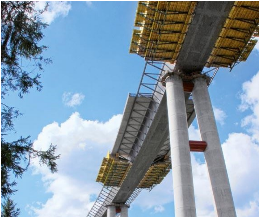
Abbildung 3.9: Talbrücke Nuttlar – unten fahrender Konsolschalwagen. Bildquelle: [24]
