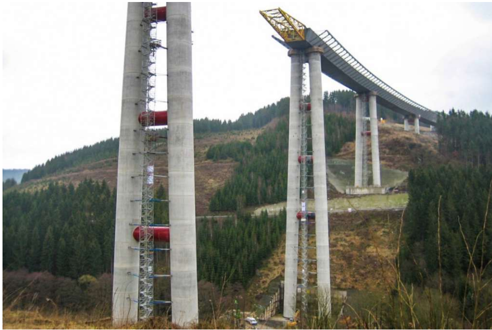
Abbildung 3.3: Talbrücke Nuttlar – Längsverschub des Stahlhohlkastens. Bildquelle: [17]
