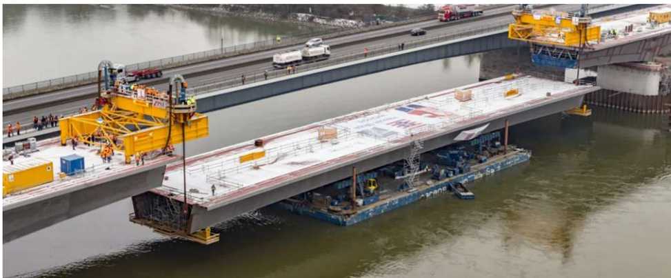
Abbildung 3.2: Schiersteiner Brücke - Einheben mittels Litzenhebern. Bildquelle: [15]
