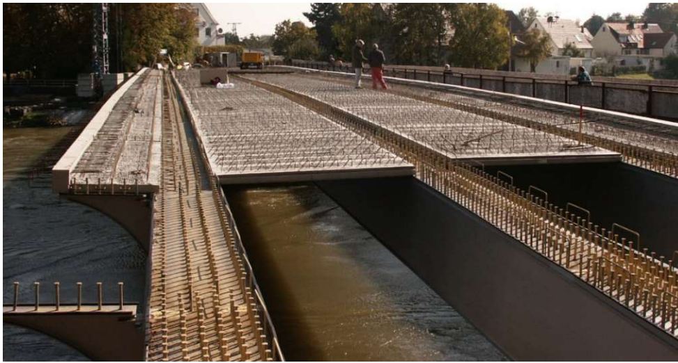
Abbildung 3.15: Donaubrücke Lauingen – Einsatz von Halbfertigteilen. Bildquelle: [6]
