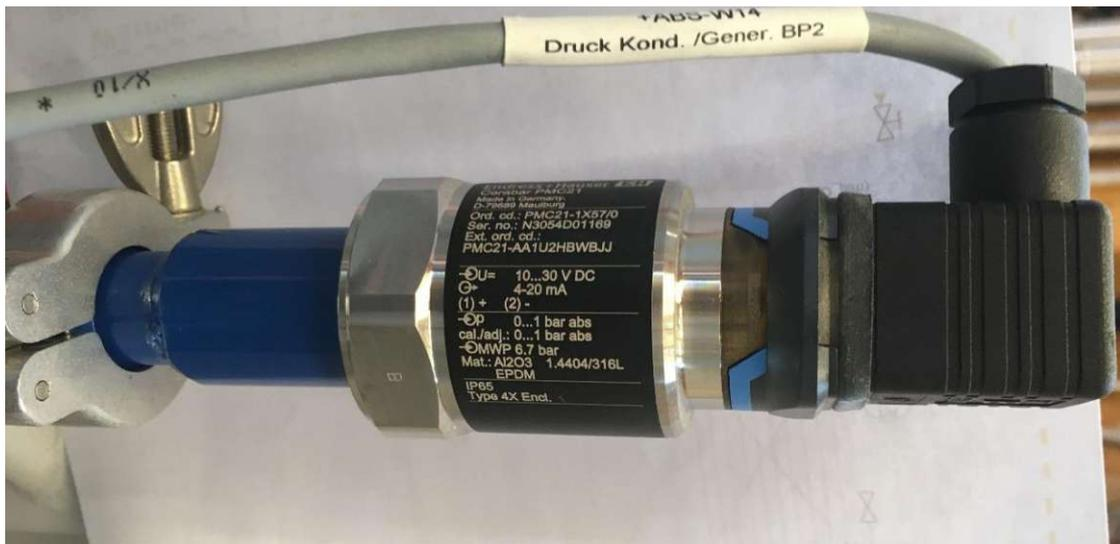
Abbildung 27: Druckmesssensor Cerabar PMC21
