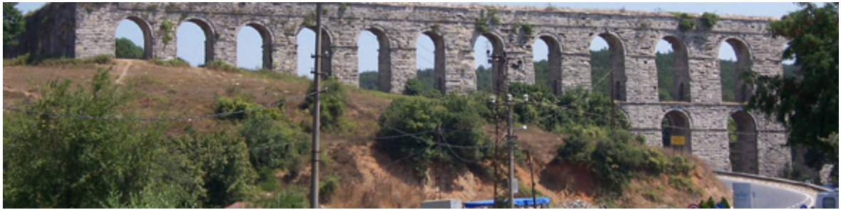
Abb. 22 Kovuk (Eğri) Aquädukt
