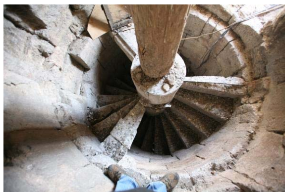
Abb.117 Treppenbündel von oben gesehen
