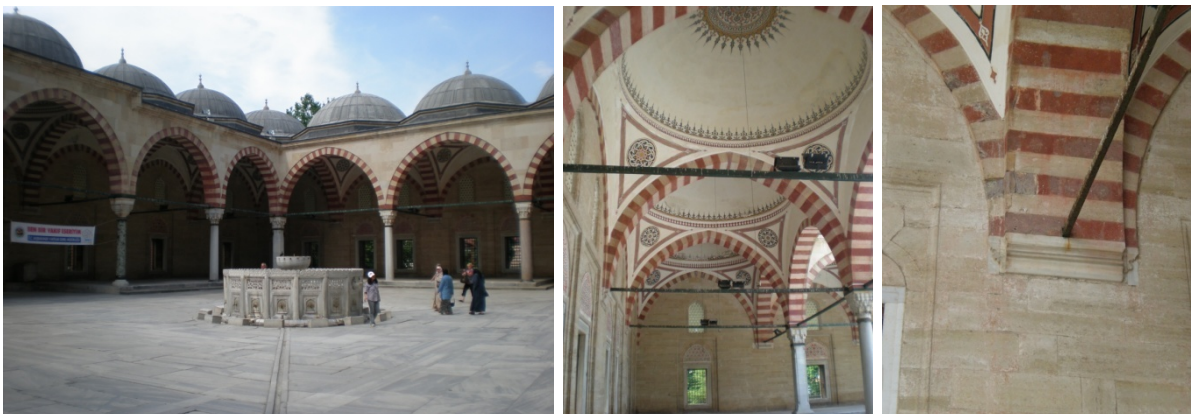
Abb. 103-105 Blick auf Innenhof, Kuppelgang und die Zugankeranschlüsse
