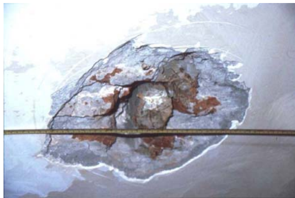
Abb.152 Einer der Resonatoren steckt in der Kuppel der Sultan-Ahmed-Moschee
