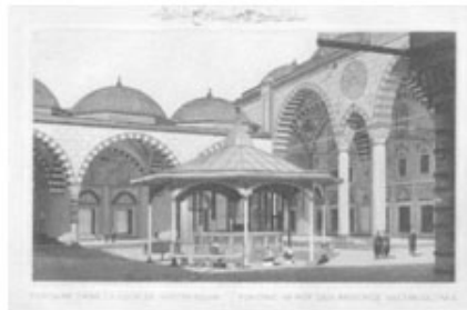
Der Sadirvan mit Dachkonstruktion
