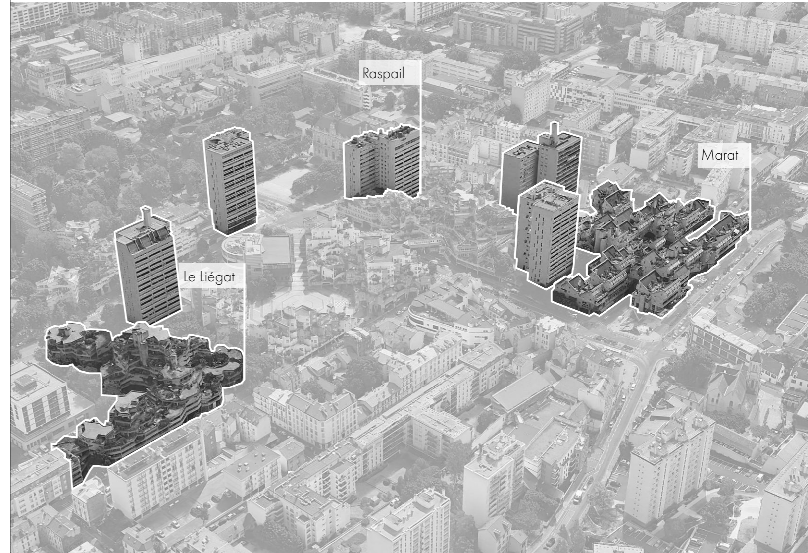
Abb. 4 | Luftbild von Ivry-sur-Seine mit den Projekten Gailhoustets hervorgehoben
