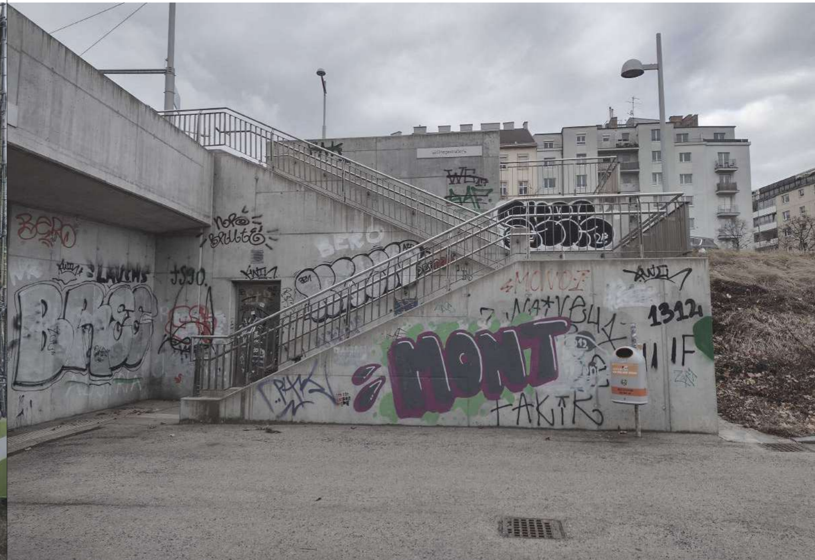
Abb. 43 | Blick auf den Bauplatz von der Unterführung aus mit dem Niveauunterschied zum Landstraßer Gürtel, 2022
