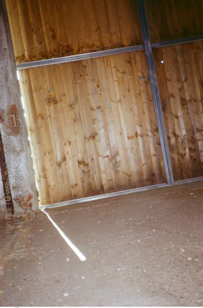
Das Eindringen des Lichts im Getreidespeicher Sep. 2021 / Yashica T3
