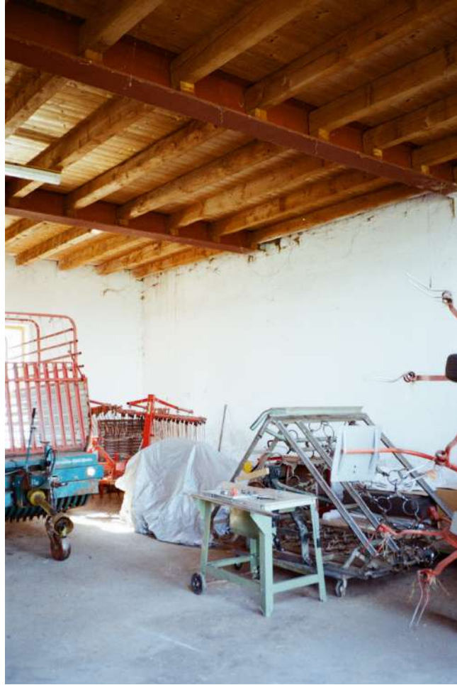
I-Träger als tragendes Element im Geräteschuppen Sep. 2021 / YashicaT3
