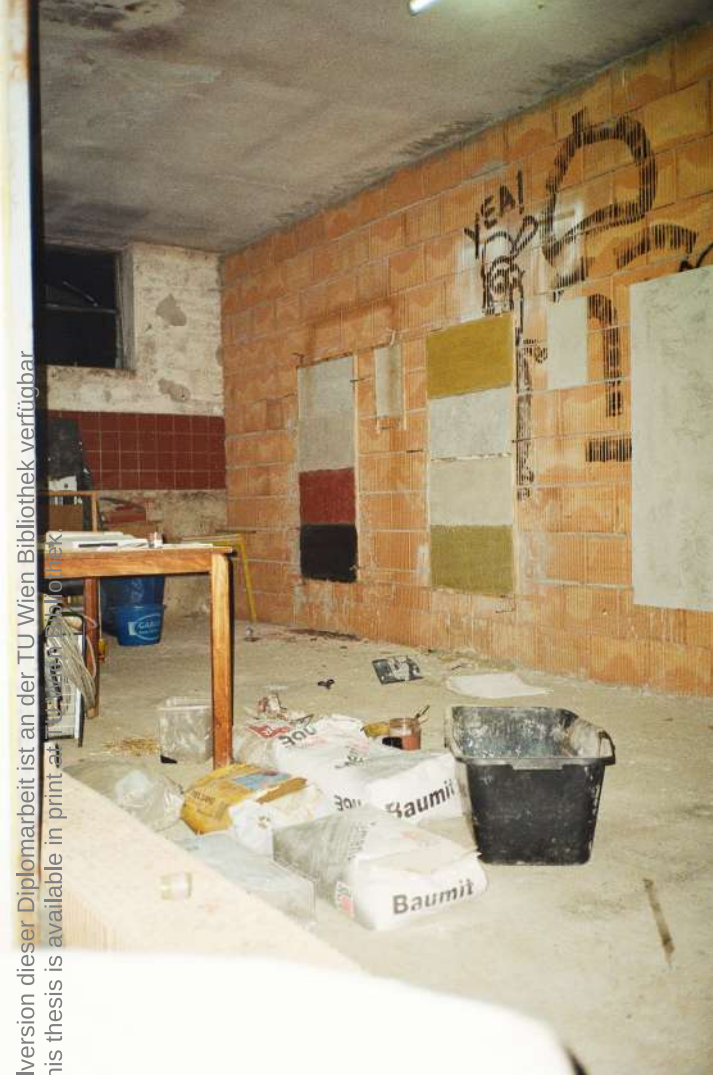
Arbeitsprozess von Grundputz zu Feinputz Sep. 2022 / Olympus Mju ii
