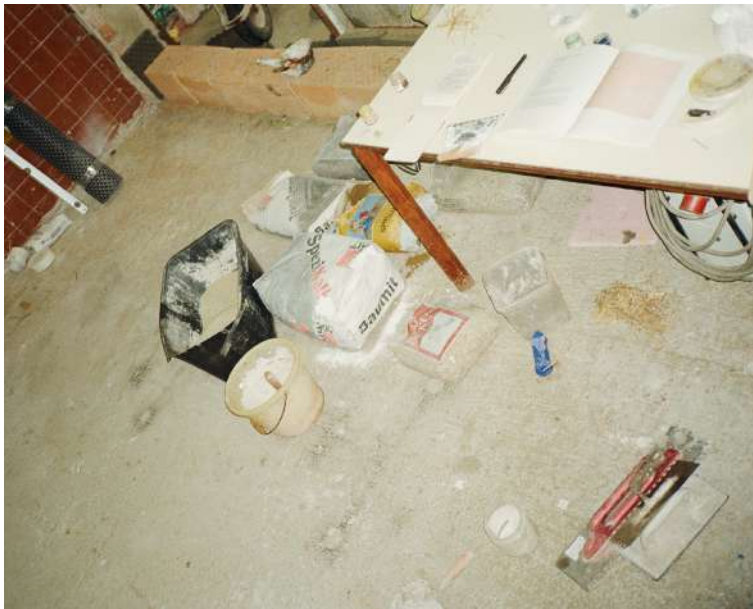
Kalkhydrat, Portlandzement, Marmorsplitt, Quarzsand, Spachtel und Kelle Sep. 2022 / Olympus Mju ii
