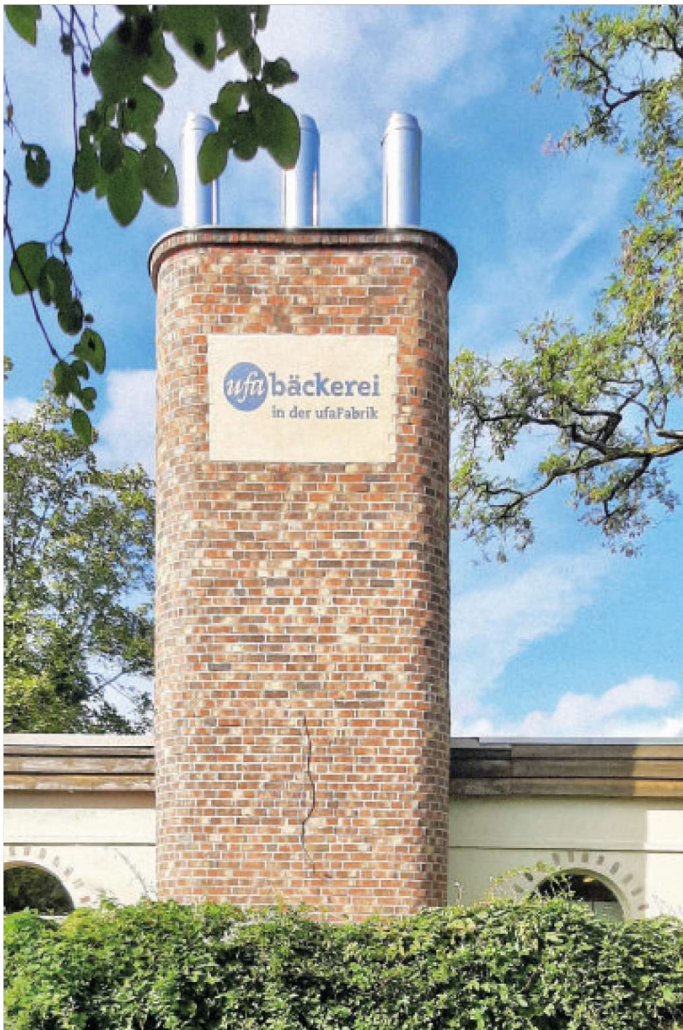
Abb.40 Kamin der Biobäckerei der ufa-Fabrik
