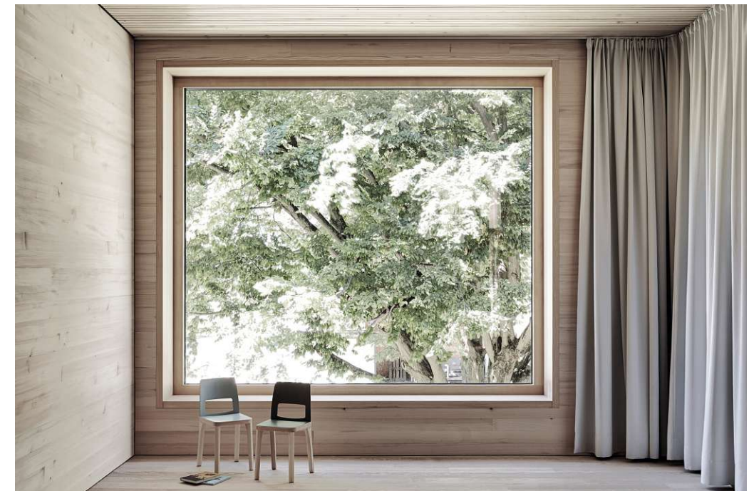
Wände mit glatter Holzoberfläche, Decke mit Holzlamellen verkleidet, großflächiges Fenster umrahmt von Holzumfassung bündig mit der Wandvorderkante
