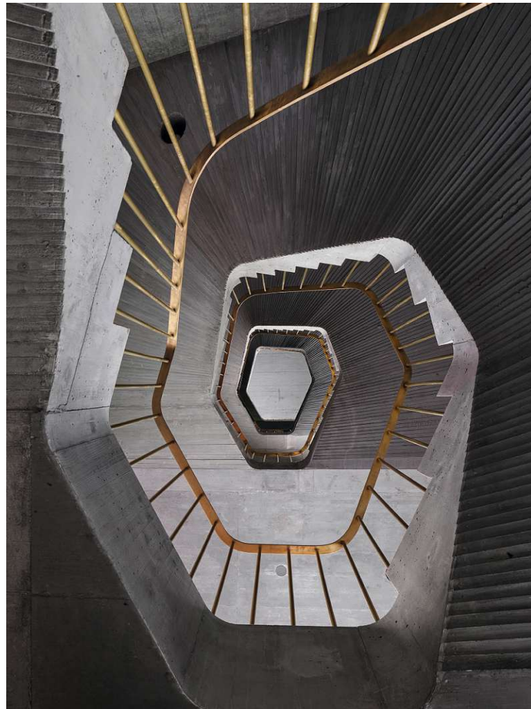
Schwere Betontreppe, an den Seiten glatt, Untersicht in gerillter Optik, feines Metallgeländer im farblichen und materiellen Kontrast, Balance aus Kanten und Rundungen
