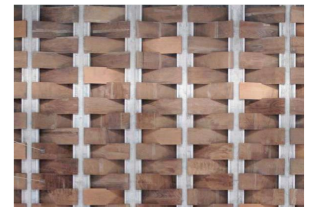
Abb. 54 | Decke: lackierte Holzplatten zwischen den Stahlbetonträgern
