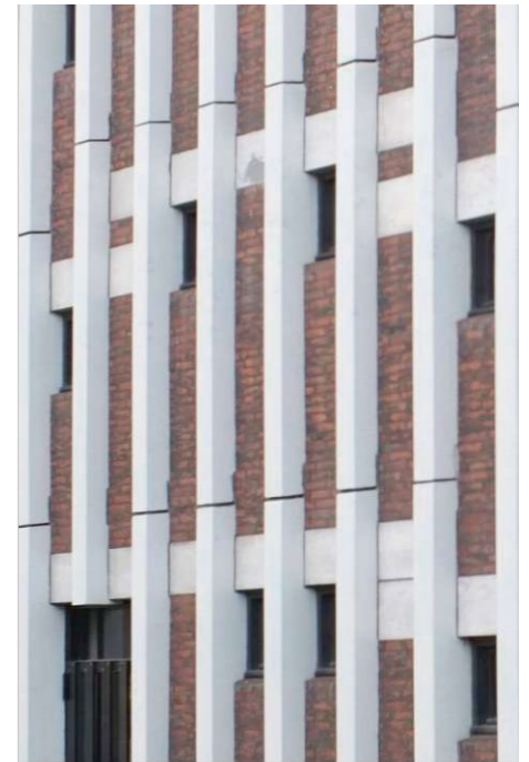
Abb. 42 | Tagensbo-Fassadenpfeiler; Kopenhagen, November 2021
