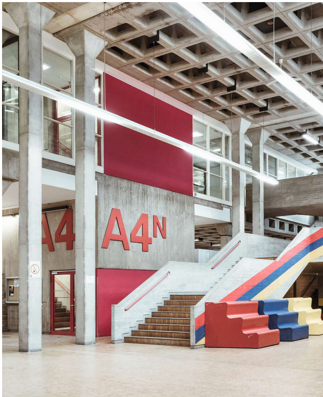
Abb. 113: Farbmarkierung des Treppen- und Aufzugskerns, Farbstreifen an Sichtbetonbrüstungen der Treppen, farbige Treppengeländer und Sitzelemente.
