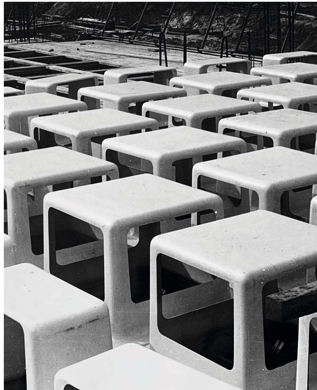
Abb. 48: Hohlraumschalungen der Deckenfelder.
