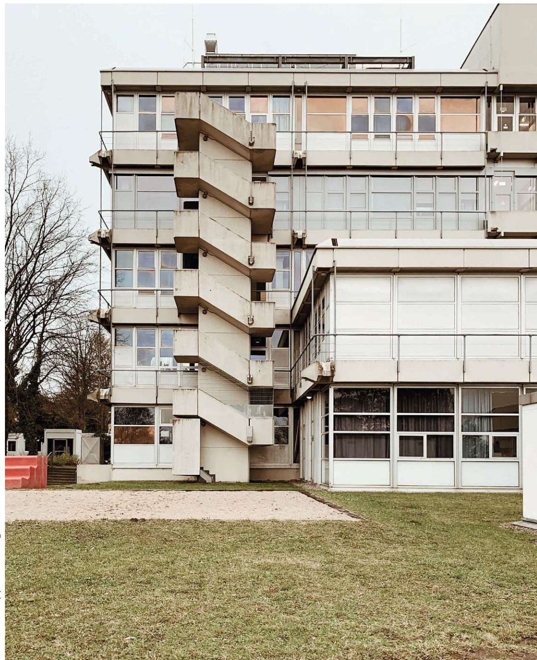
Abb. 60: Vorhangfassade mit Betonelementen.
