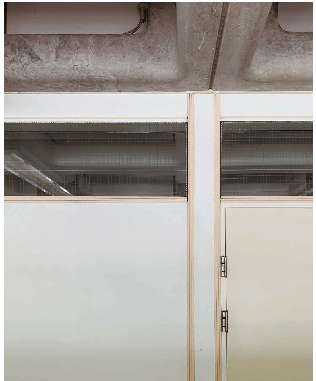
Abb. 89: Innenwandanschluss an Deckenkonstruktion.
