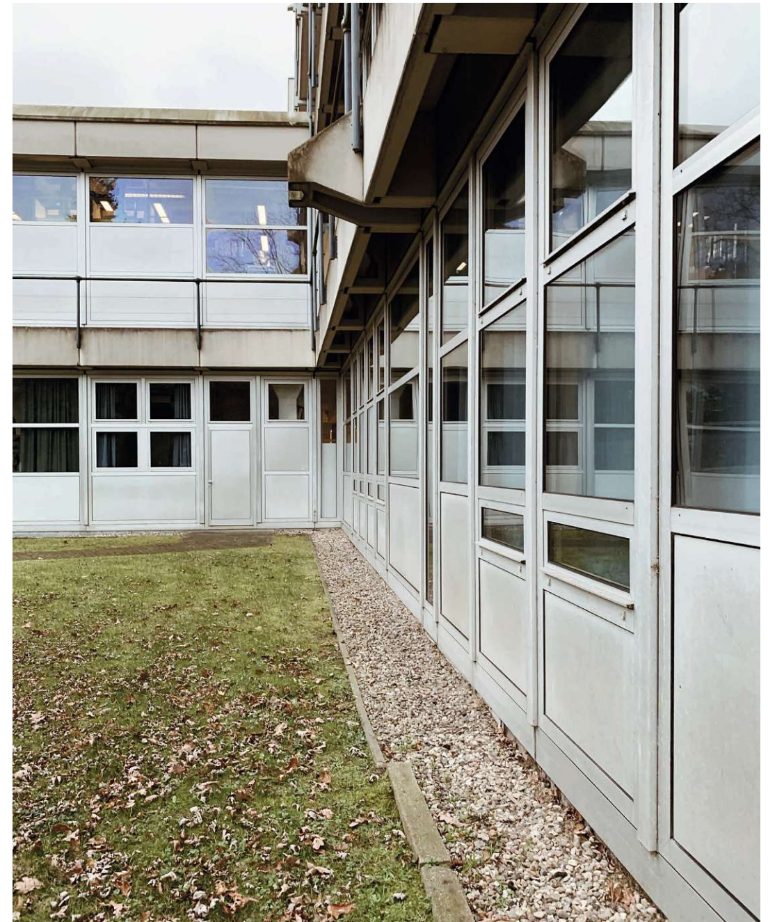
Abb. 85: Aluminiumfassade mit Verglasung und Paneelen.
