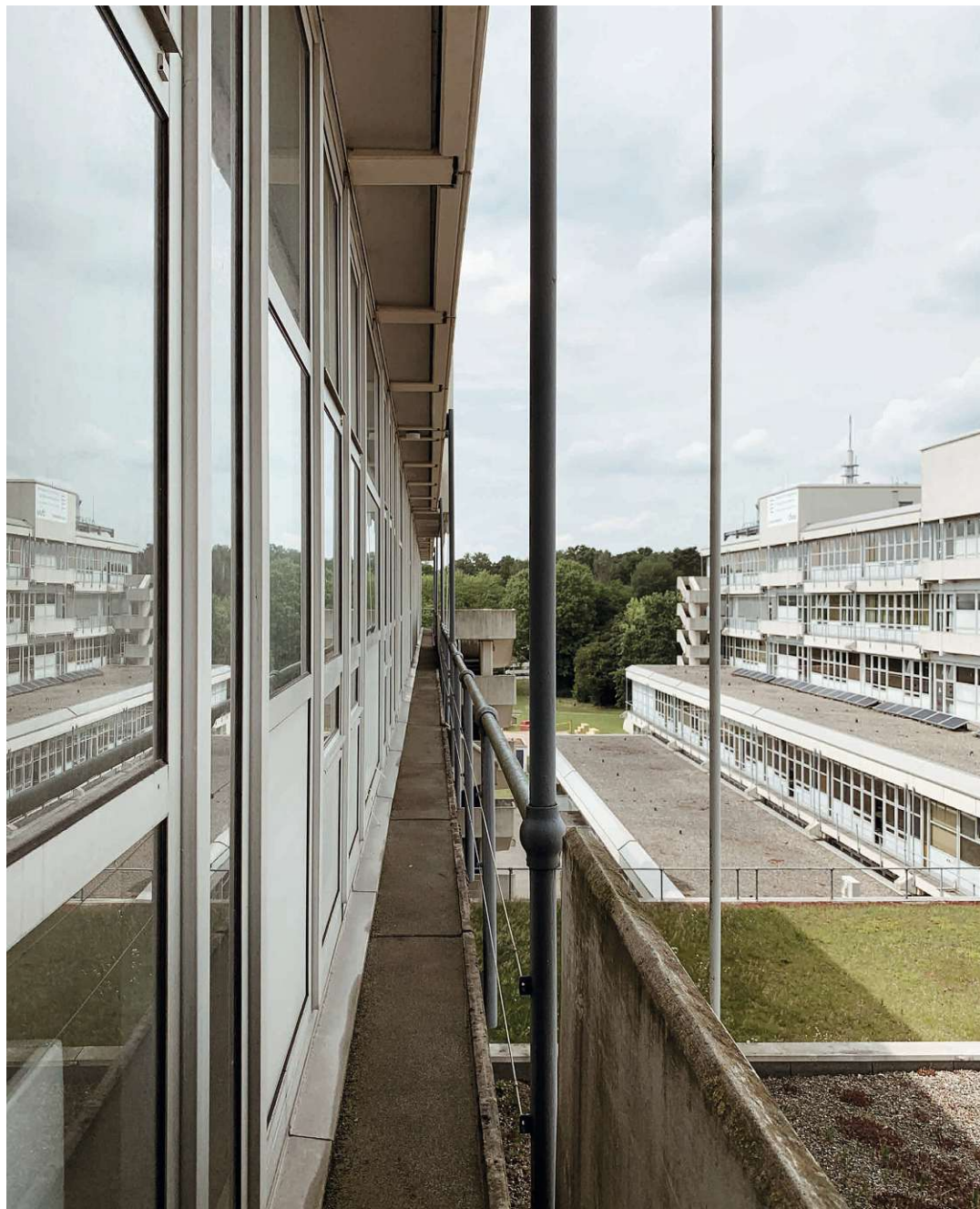
Abb. 88: Fluchtbalkone und Fluchttreppen.
