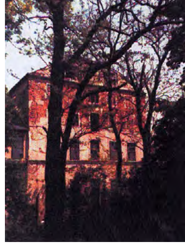
Abbildung 48: Fassade der alten Spinnerei Teesdorf, Ziegelmauerwerk
