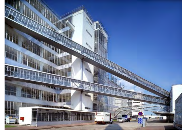
Abbildung 71: Van Nelle Fabrik, Verbindungsbrücken, Foto
