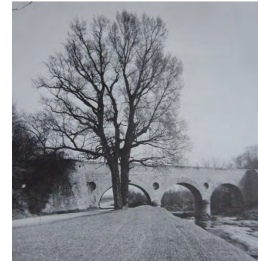
Abbildung 46: "Die drei Schwibbögen", Werkskanalbrücke über die Triesting
