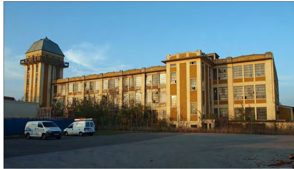
Abbildung 9: Das Spinnereigebäude in Teesdorf, Foto
