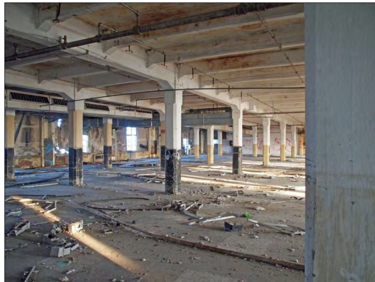
Abbildung 12: Stützen- und Deckenraster in den Produktionshallen, Foto
