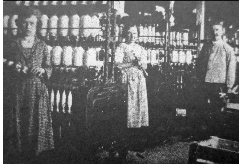
Abbildung 44: Ringspinnmaschinen der Spinnerei Teesdorf um 1900
