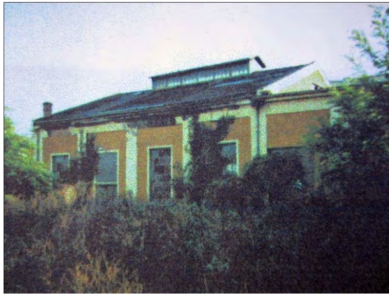
Abbildung 8 Nordfassade der Elektrozentrale, Foto von 1999
