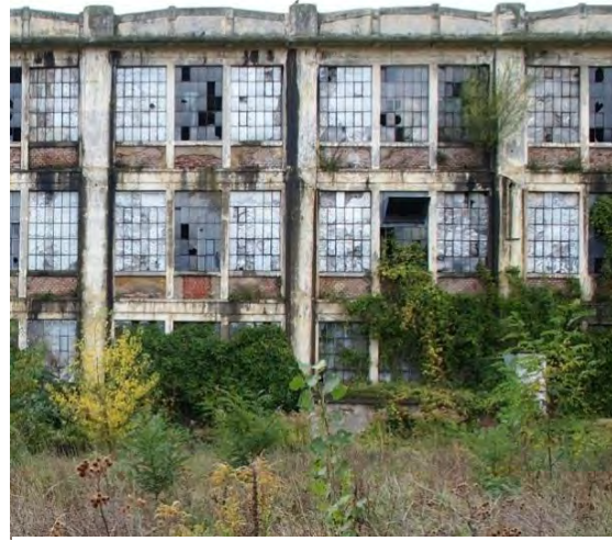
Abbildung 47: Fassade des Neubaus der Spinnerei Teesdorf, Stahlbetonskelettbau
