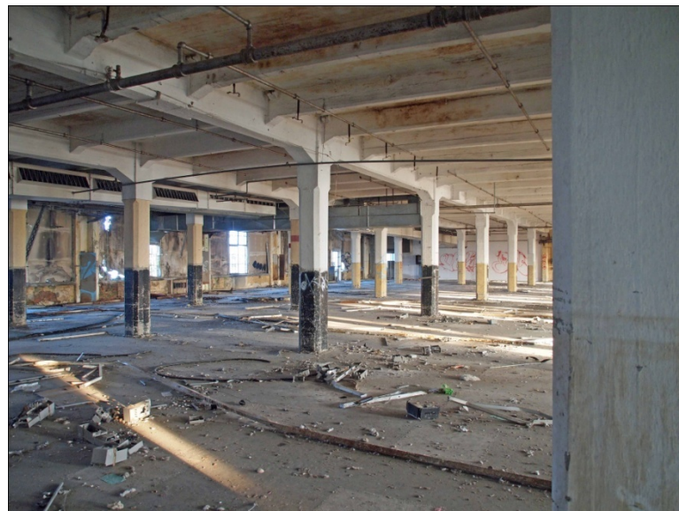
Abbildung 12: Stützen- und Deckenraster in den Produktionshallen, Foto
