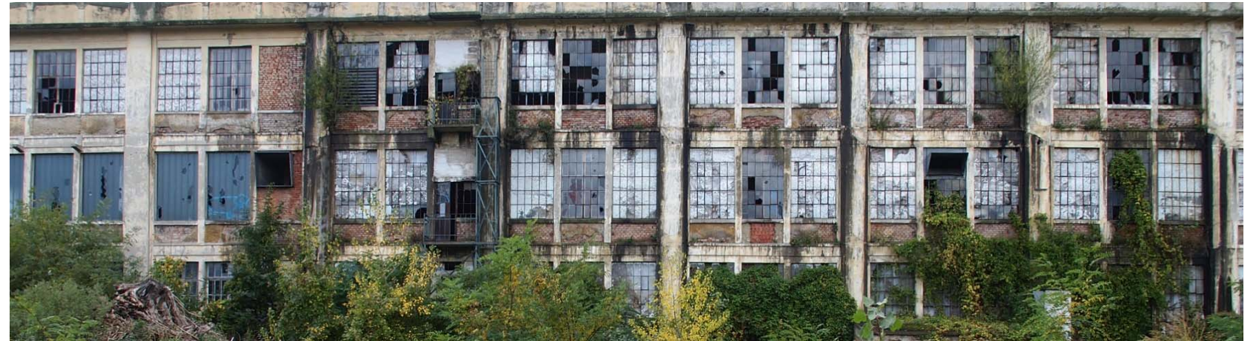
Abbildung 66: Spinnerei Teesdorf, Ansicht der Längsfassade, Verhältnis Glas zu Mauerwerk, Foto
