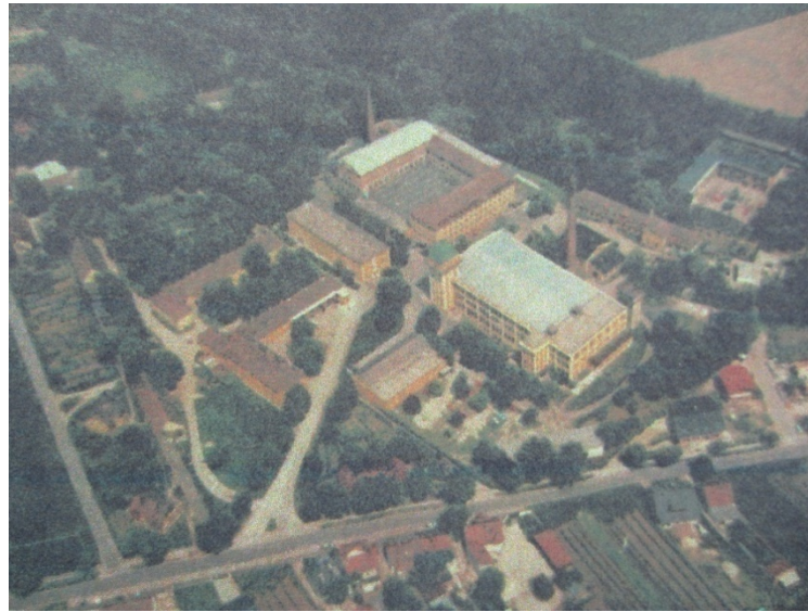
Abbildung 6: Das ehemalige Ensemble, Luftaufnahme von 1982
