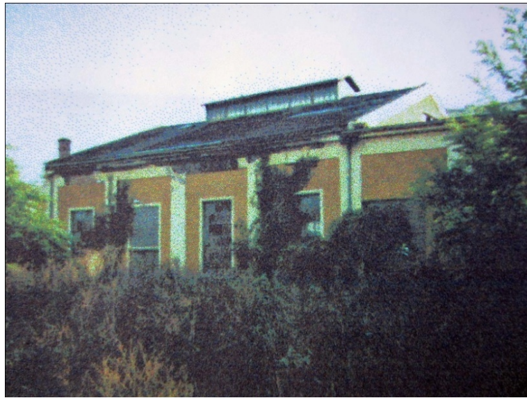
Abbildung 8 Nordfassade der Elektrozentrale, Foto von 1999
