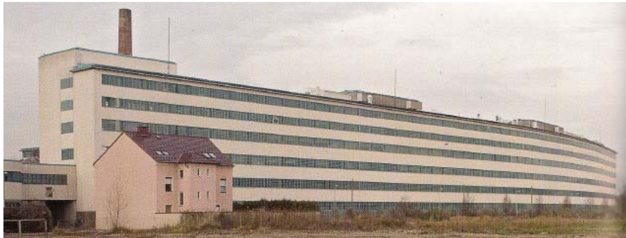
Abbildung 76: Tabakfabrik Linz, Ansicht Fabrikationsgebäude, Foto
