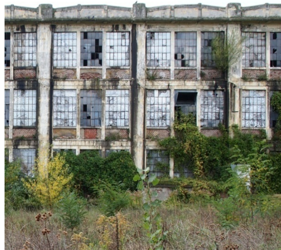
Abbildung 47: Fassade des Neubaus der Spinnerei Teesdorf, Stahlbetonskelettbau
