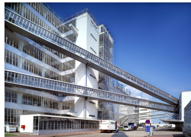
Abbildung 71: Van Nelle Fabrik, Verbindungsbrücken, Foto
