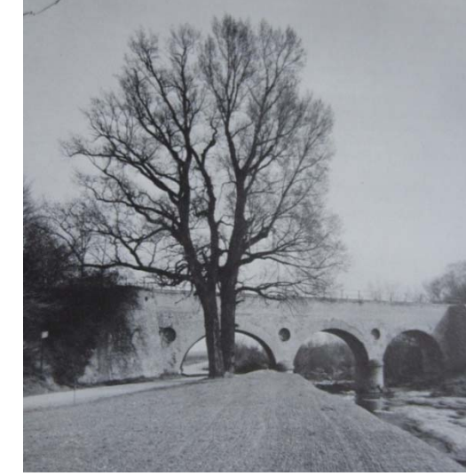
Abbildung 46: "Die drei Schwibbögen", Werkskanalbrücke über die Triesting
