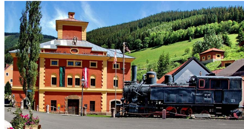
Abbildung 61: Foto des unter Denkmalschutz gestellten Radwerk IV, Vordernberg
