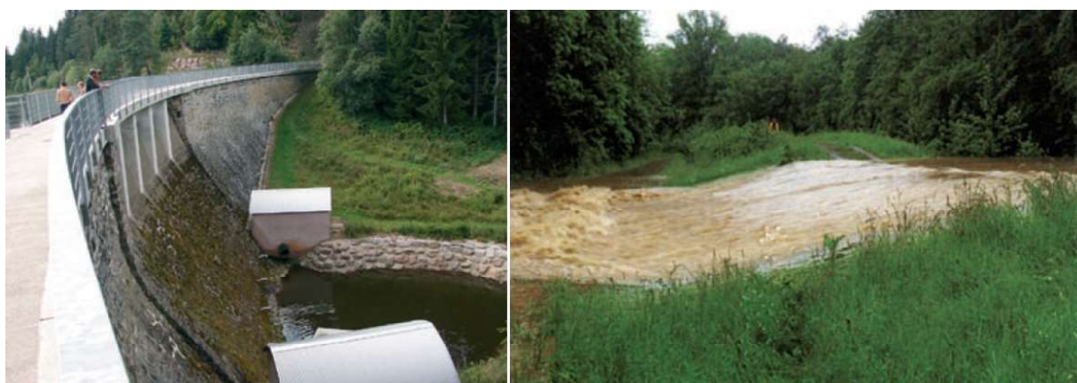
Abb. 45: Links: Stirnentlastung; Rechts: Dammscharte Quelle: LUBW Landesanstalt für Umwelt, Messungen und Naturschutz Baden-Württemberg 2008, S. 21, 24
