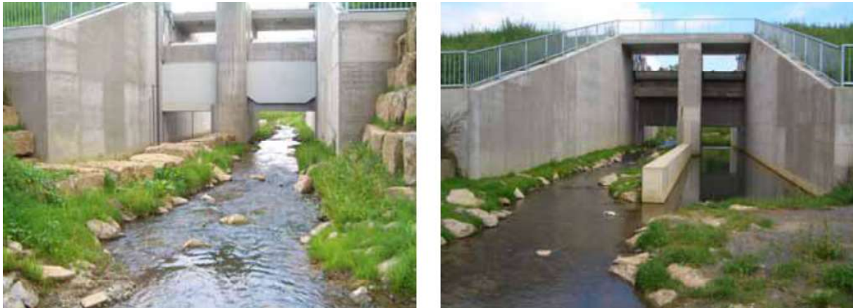
Abb. 40: Links: Einlauf; Rechts: Auslaufbauwerk
