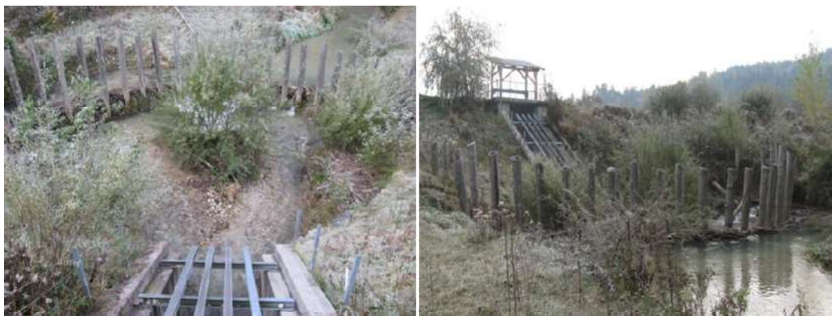
Abb. 43: Vorgelagerte Pfahlrechen
