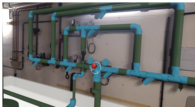
Bild 3. Überlagerung des AR-Modells mit der Verrohrung (roter Pin markiert Mangel), Screenshot aus Microsoft HoloLens 2 Grafik: Breitschopf
