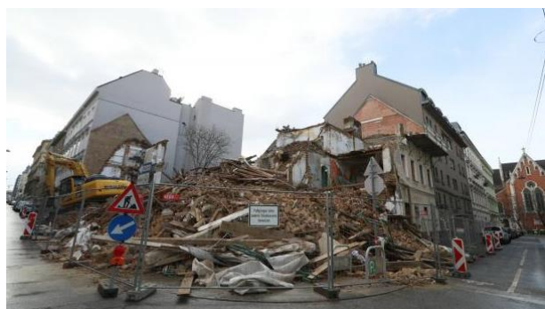
Abbildung 14: Gasthaus Sperl nach erfolgtem Abbruch im Jänner 2019. Quelle: Kurier.
