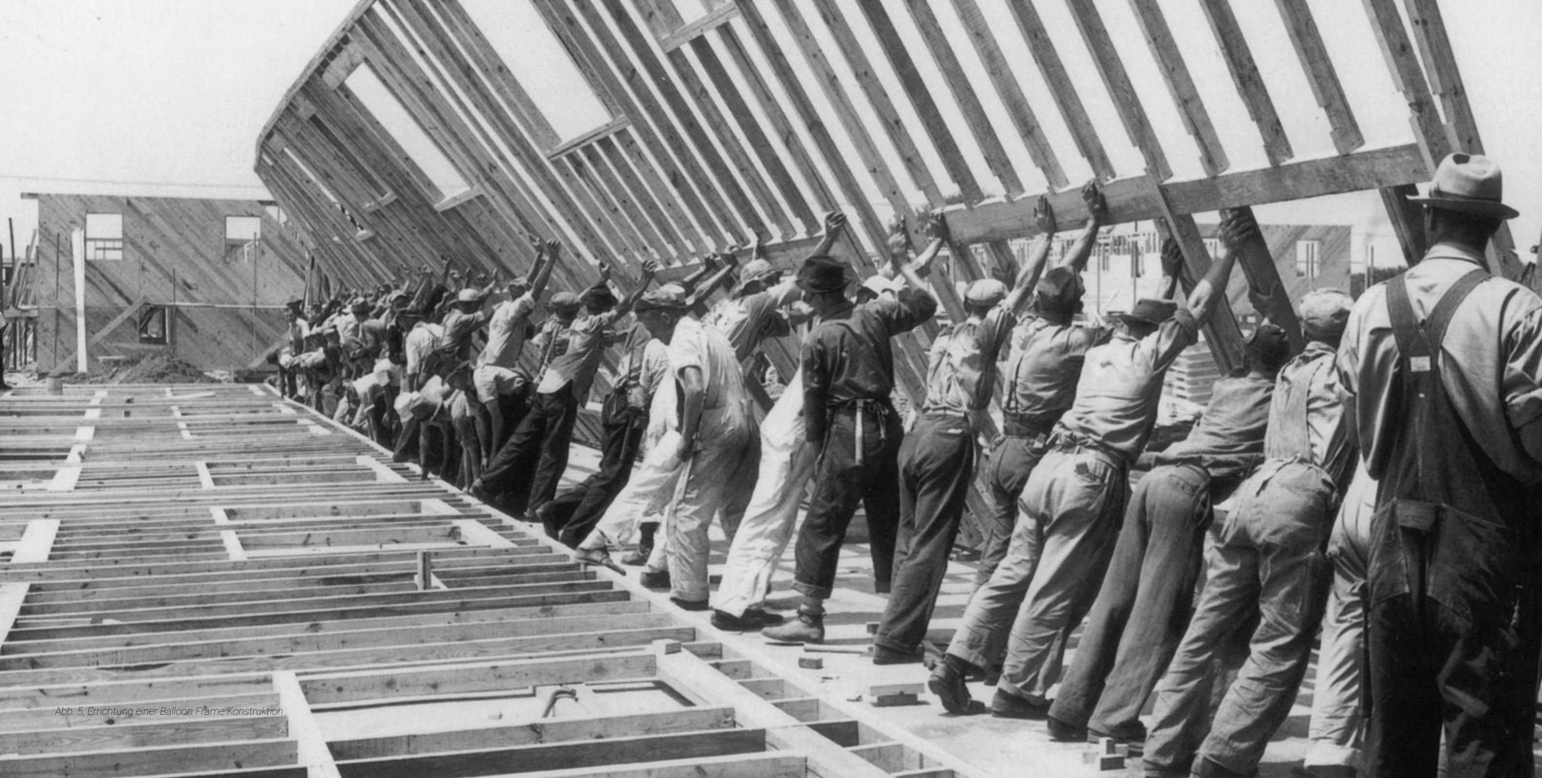
Abb. 5, Errichtung einer Balloon Frame Konstruktion
