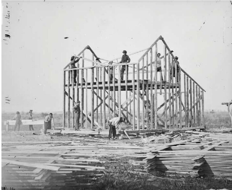
Abb. 1, Balloon Frame Konstruktion
