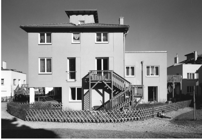
89 – Hermann Czech, „Wohnsiedlung Franz Kamtner Weg 1-9“, angebaute Außenstiege und Holzlattenzaun.
