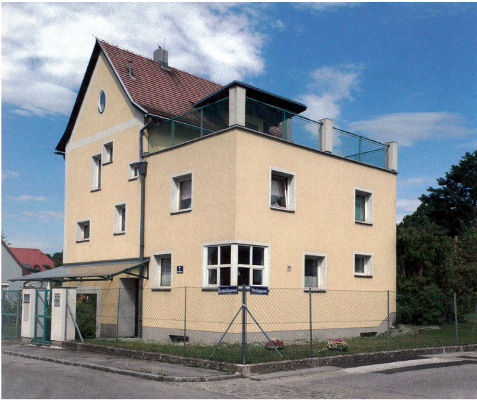
34 – Hermann Czech, „Haus M.“, Schwechat, 1977-1981, Außenauf- nahme.
