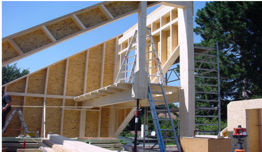
Beispiel eines Holzrahmenbaues
