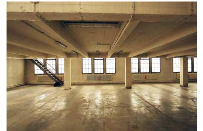
Abb. 160: Unteransicht des Trägerrosts eines Magazingeschoßes
