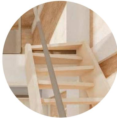
Abb. 200: Holzterrasse mit versetzten Stufen
