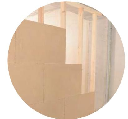
Abb. 192: Lehmbauplatten als Beplankung
