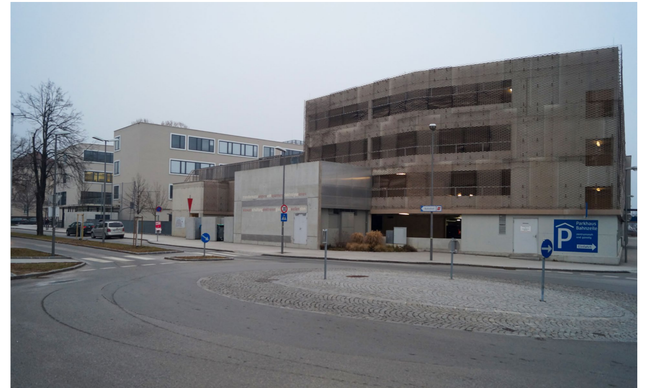
Abb. 44 Schulzentrum und Parkhaus Bahnzeile, Kreams an der Donau
