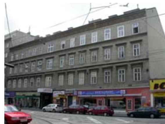
Abb. 8.8: Viergeschoßiges Gebäude Jägerstraße 35 Straßenfassade Ost-orientiert
