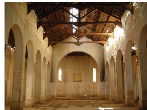
16. 17. Tigrinna, il portico di ingresso, rivestito in travertino. L'interno a tre navate con copertura lignea (2005).
