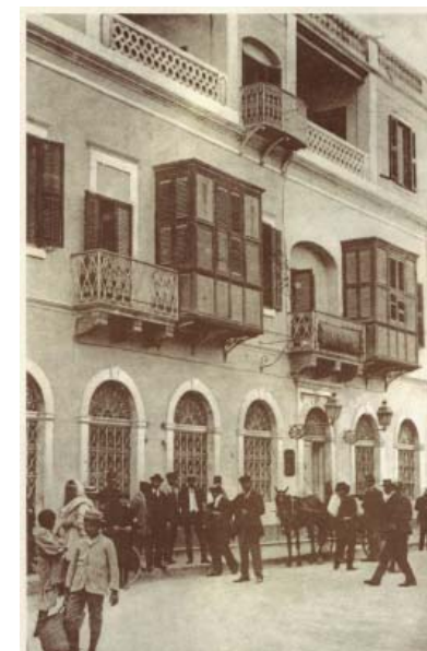
4. cartolina con la piazza del banco di Roma e l'edificio del banco.
