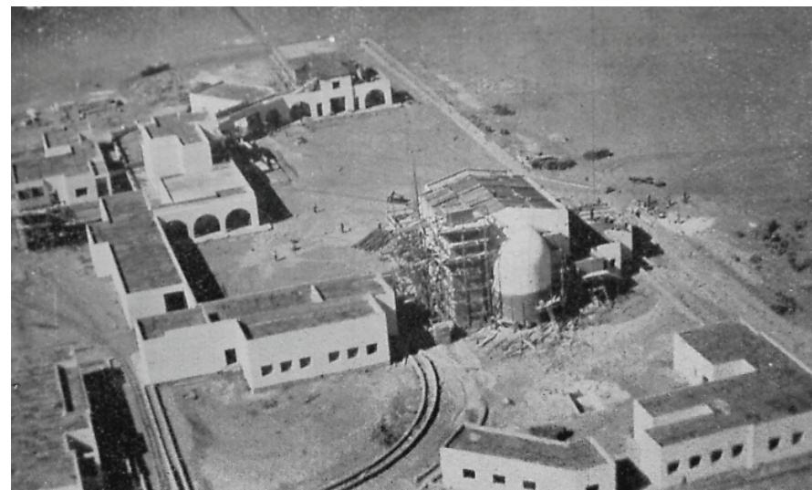
124. fotografia dal "retro" del centro. La chiesa è in costruzione.
