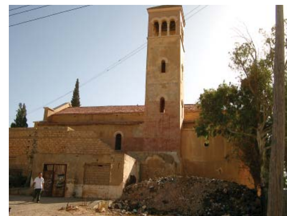
18. il campanile in stile romanico, con la trifora in travertino.
