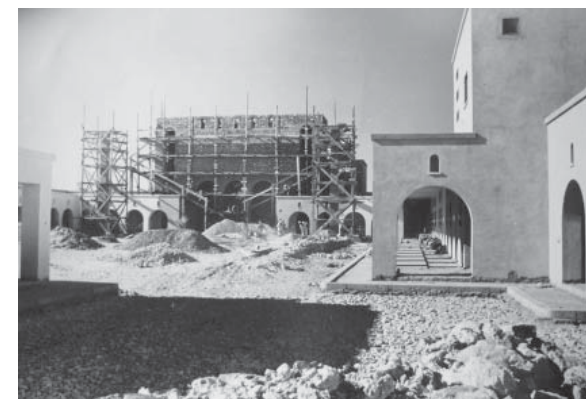
6. la chiesa di Oliveti in costruzione.
