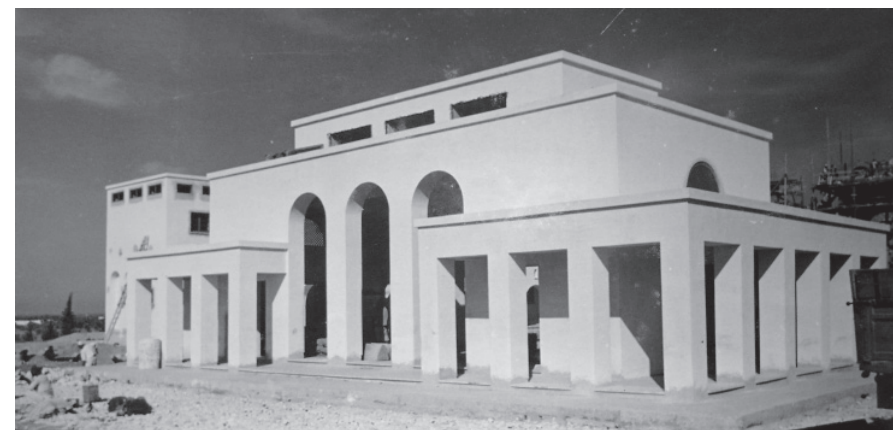
71. 72. il centro realizzato, l'edificio del mercato, tra la strada e la piazza centrale.
