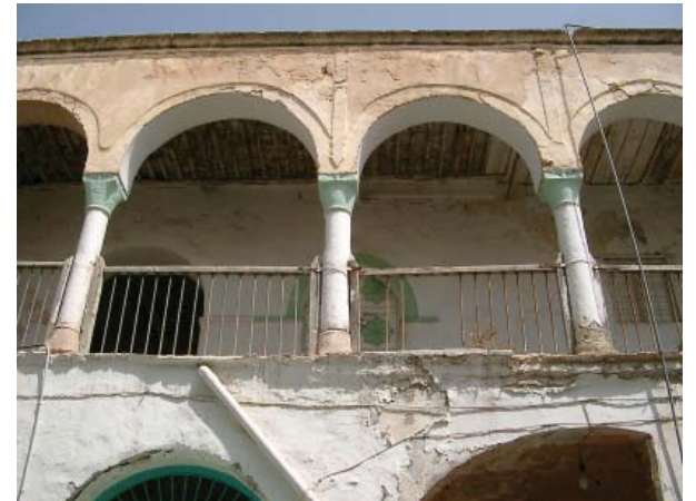
24. 25. archi all'interno delle abitazioni, paralleli al cortile interno, usati per aprire i corridoi distributivi sulla corte.
