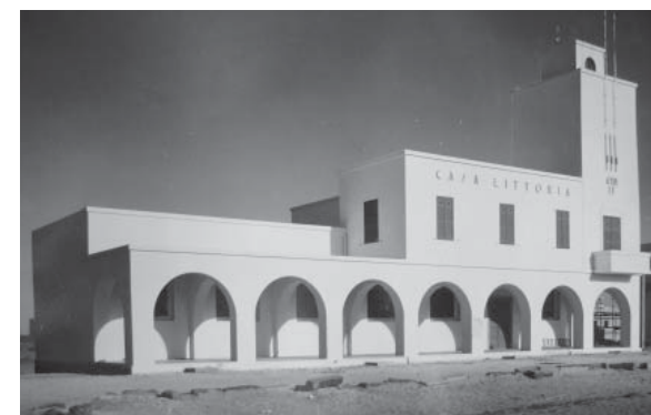
7. 8. Bianchi, la chiesa e la casa del fascio, entrambi caratterizzati da un portico continuo al piano terra.
