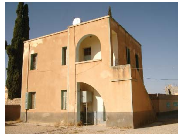
19. uno degli edifici sulla piazza di Tigrinna (abitazione degli insegnanti?). Lo stile si differenzia completamente rispetto a quello dalla chiesa.
