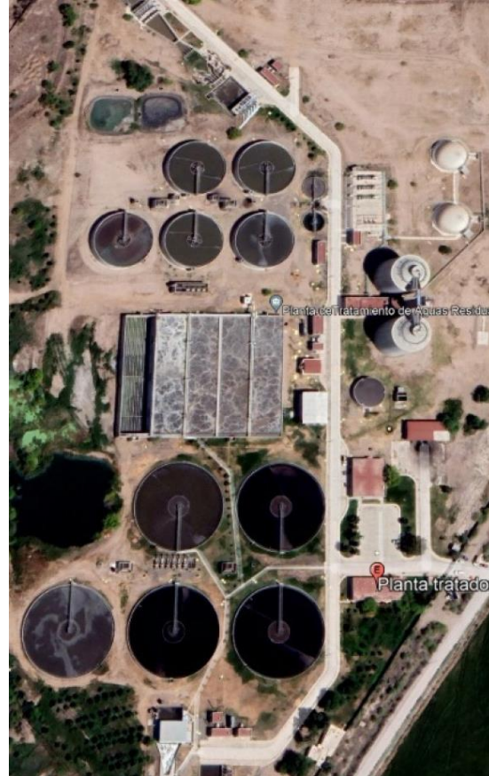
Planta de tratamiento de agua con producción de biogas en Hermosillo, México
