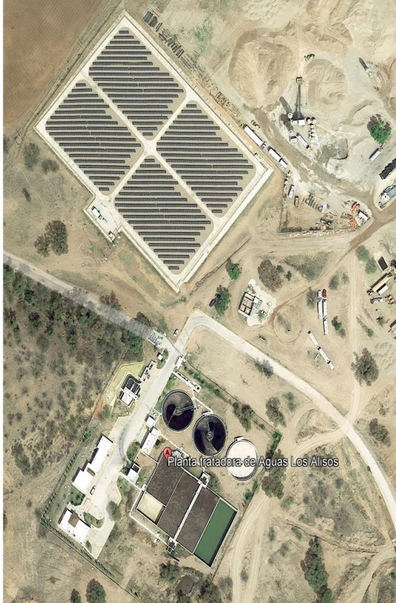
Planta de tratamiento de agua alimentada por energía solar en Nogales, México
