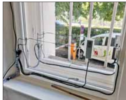
Abbildung 4 Messtechnik am Objekt
