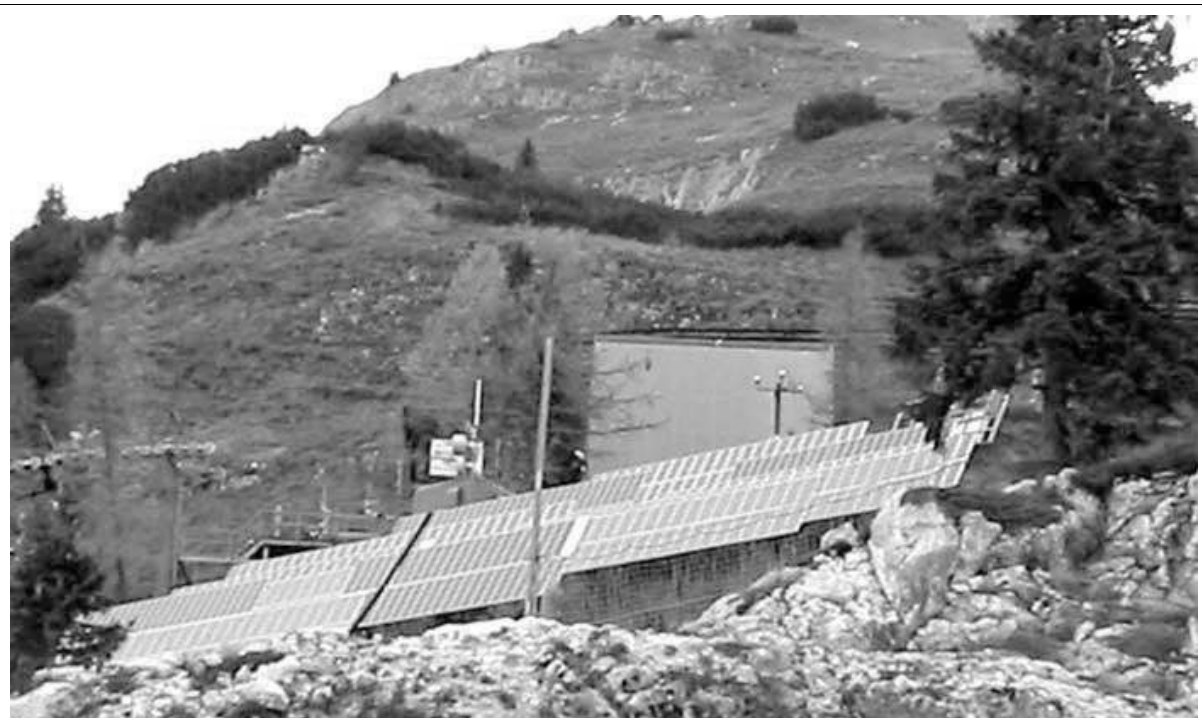
Abbildung 1.1.2: Sonnenkraftwerk Loser in Oberösterreich, das derzeit größte Sonnenkraftwerk in den Alpen
