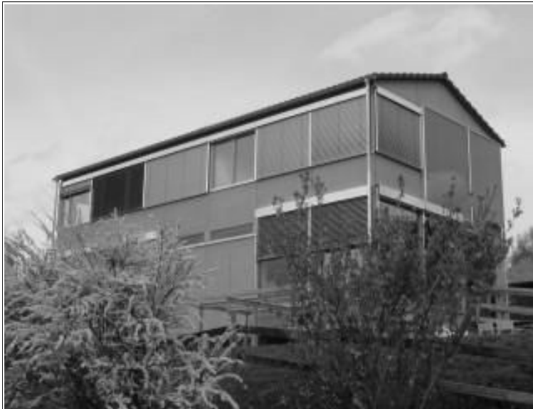
Abbildung 1.2.1: Einfamilienhaus Eberle in Übersaxen, Vorarlberg, ca. 900 m Seehöhe, Nahe Passivhaus in Holzbauweise, (Quelle: IG Passivhaus Österreich)
