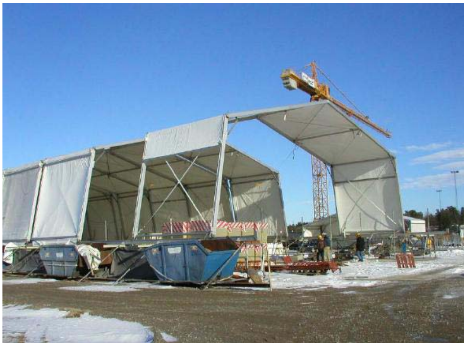
Abbildung 5: Schulsanierung in Schweden, leichte, industriell gefertigte und verschiebbare Zeltsegmente, Quelle: Rationalisierungs- und Innovationszentrum der Deutschen Wirtschaft e.V.
