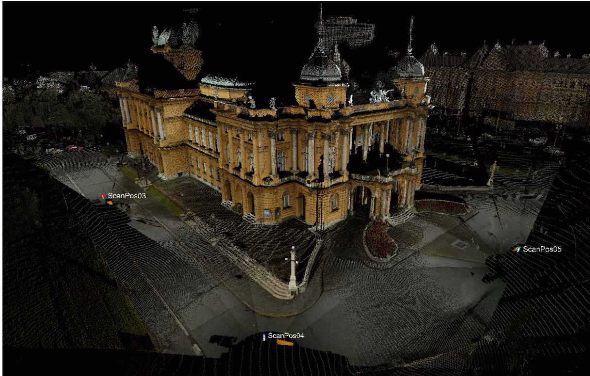
Abbildung 5.14: Aus 3 Scanpositionen stammende eingefärbte Punktwolke zweier Fassaden des Nationaltheaters Zagreb.
