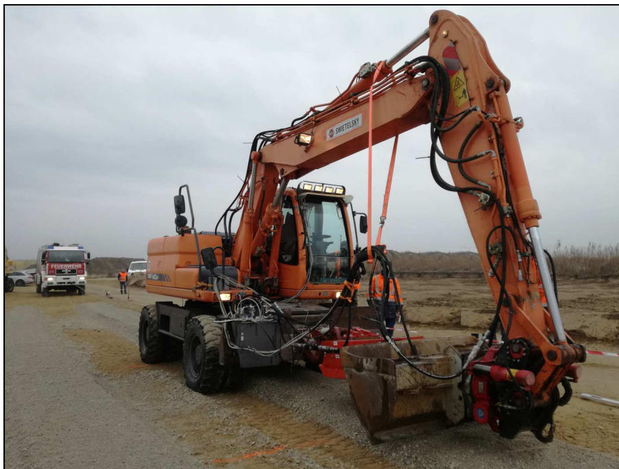
Abbildung 7.5: Von Seilwinde gezogener Hydraulikbagger mit Plattenverdichter; Versuchsfeld in Fischamend
