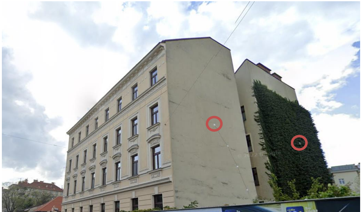
Abb. 6: Ansicht des Gebäudes in der Kopalgasse
