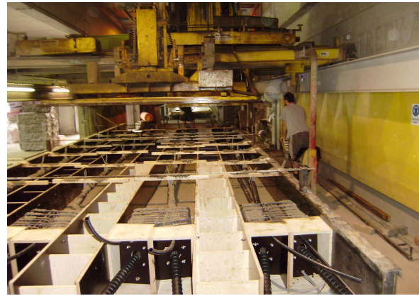
(b) Lagenweises Betonieren
