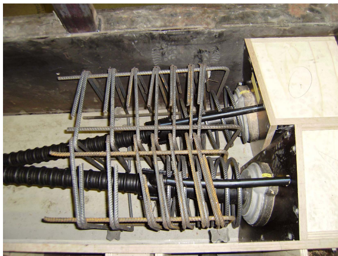
Abbildung 4.1: Bewehrung zur Aufnahme der Vorspannkräfte
