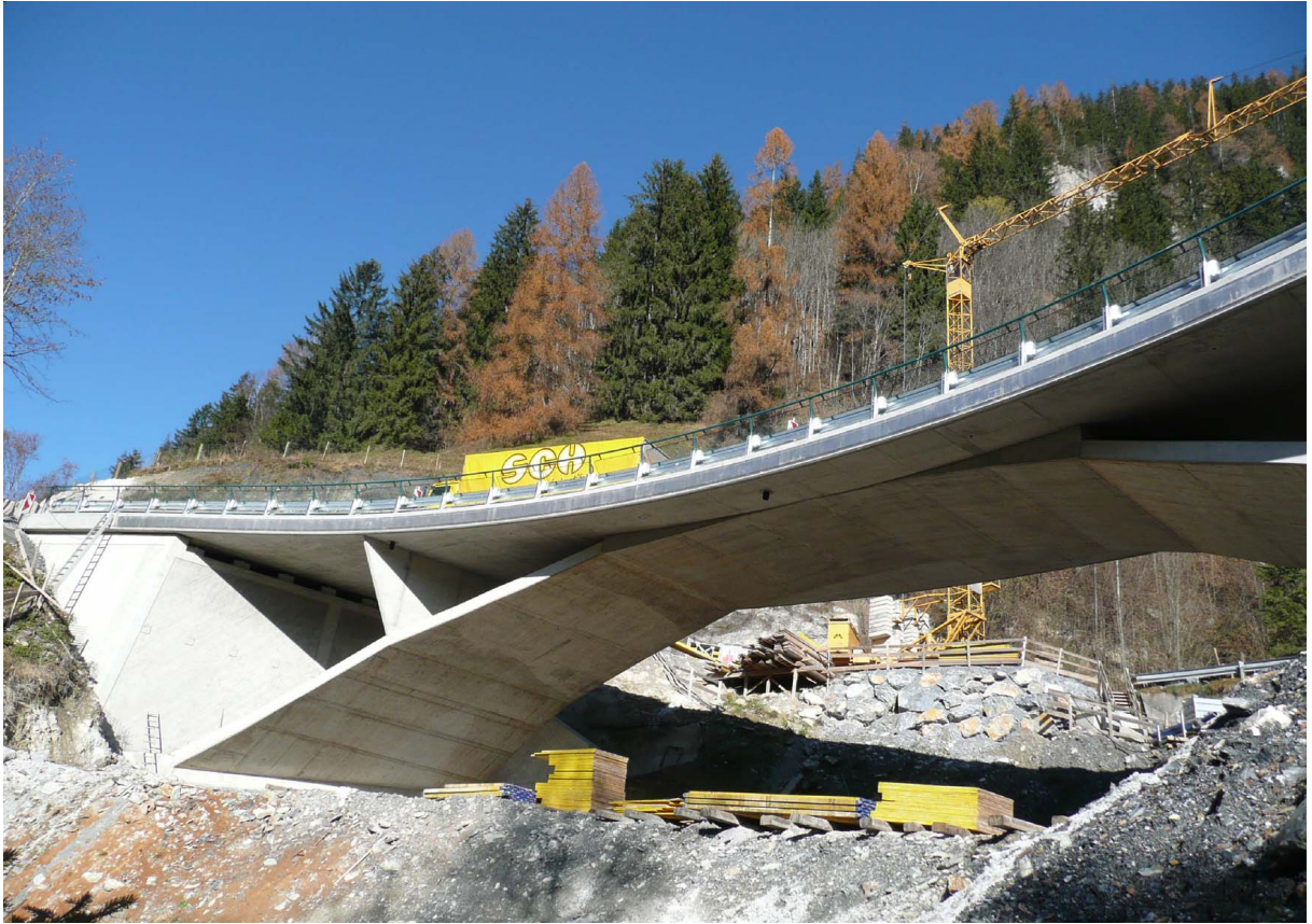
Abbildung 2.3: Egg - Graben Brücke (Foto: Matthias Seidl, ALPINE Bau GmbH)
