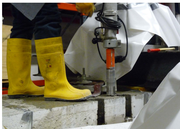
Abbildung 4.20: Bohrgerät für Prüfung Abreißfestigkeit
