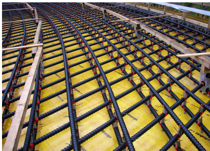
Abbildung 2.2: Anordnung der Bewehrung Egg-Graben Brücke
