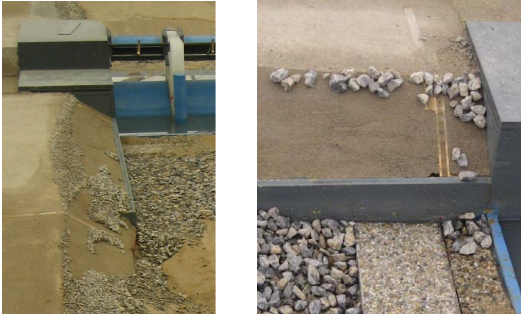
Abbildung 85: Wehrseitige Böschung im Unterwasser
